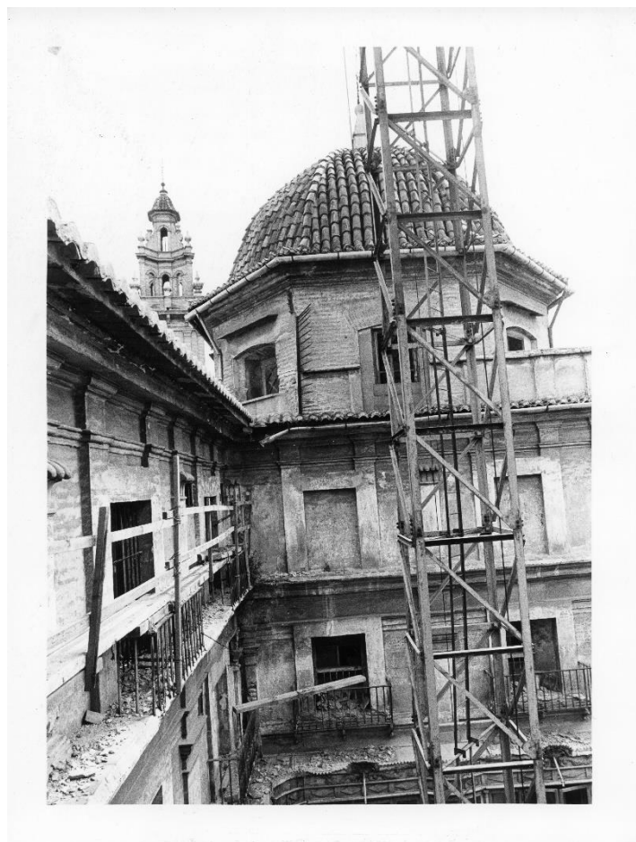
Figura 27. Patio interior del palacio, en fase de rehabilitación
