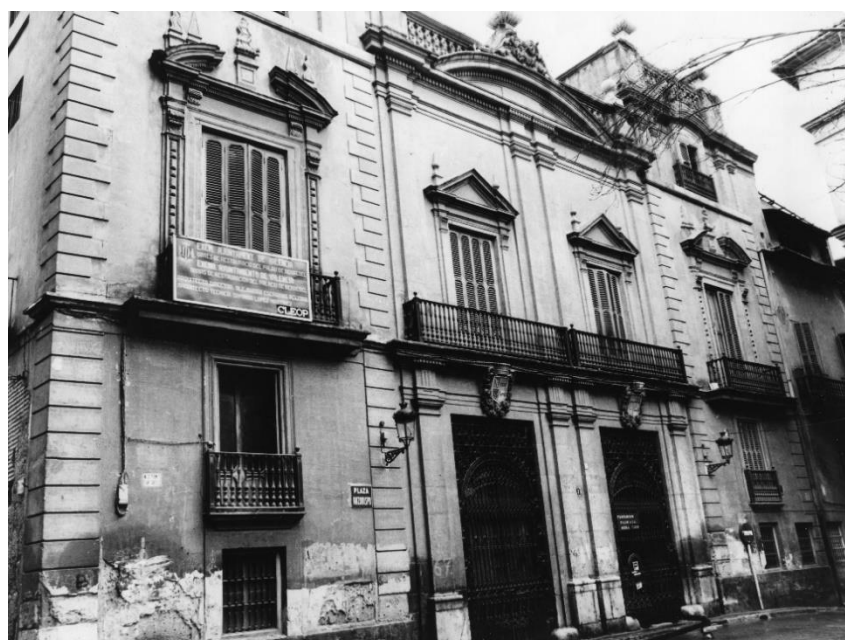
Figura 25. Fachada del antiguo palacio de los condes de Almenara, actual Museo de la Ciudad de Valencia
