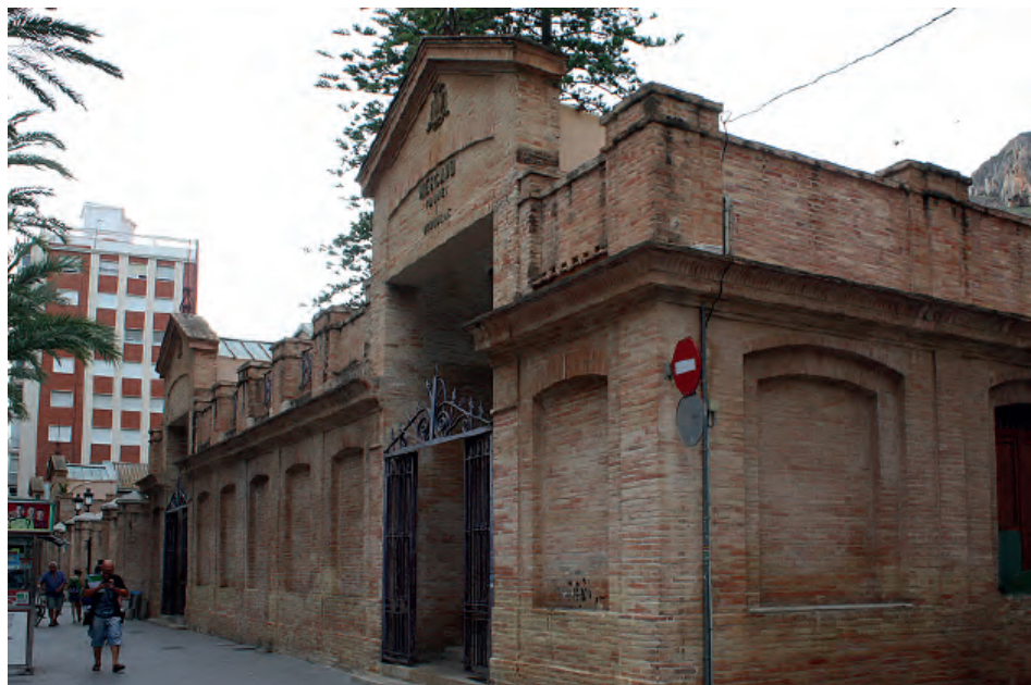
Fig. 12. Exterior del mercado de Cullera, Sección segunda, 2014. Fotografía: A. Besó.
