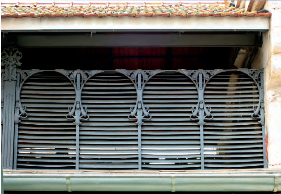
Fig. 16. Claristorio de la nave del mercado de Alginet, 2017. Fotografía: A. Besó.
