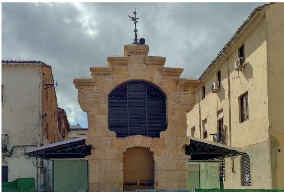
Fig. 21. Fachada del mercado de Alginet, 2017. Fotografia: A. Besó.
