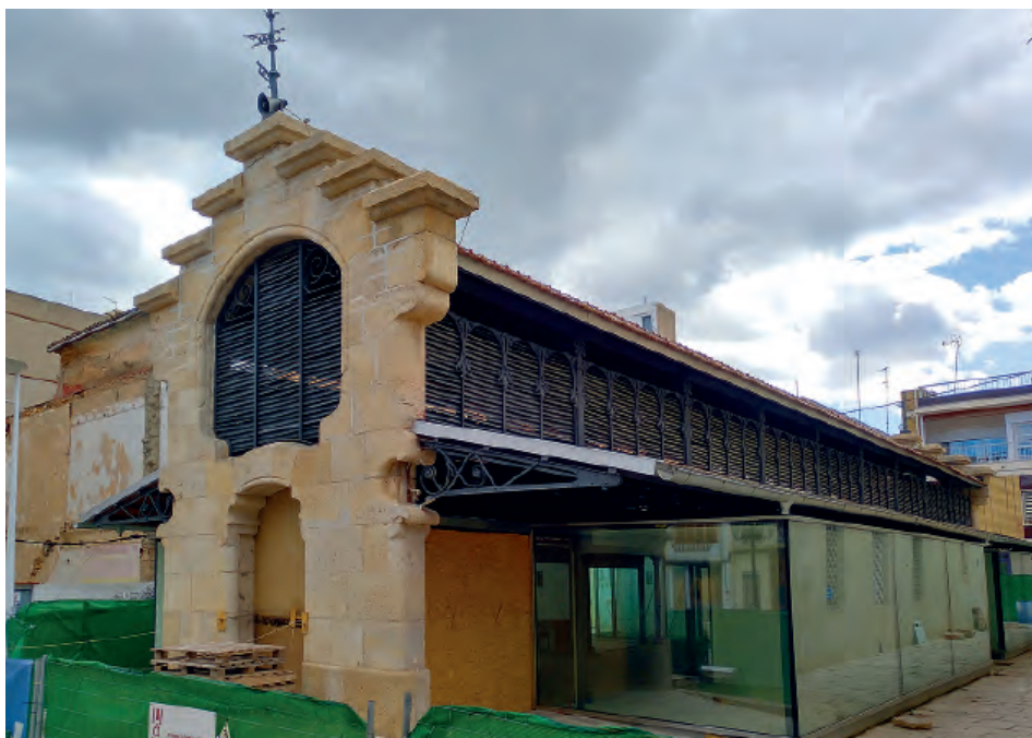
Fig. 22. Mercado de Alginet en restauración, 2017. Fotografia: A. Besó.
