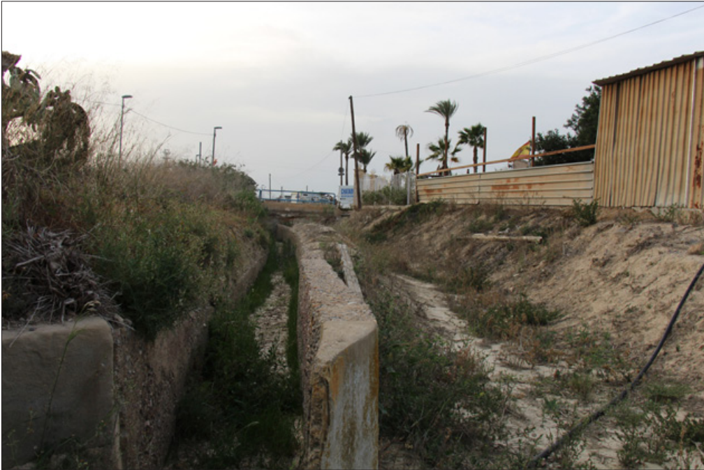
Figura 5.10: Bifurcación en la acequia principal del sistema de boqueras de Tiñosa. Fuente: Autor.
