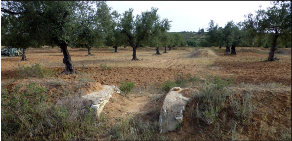
Figura 3.45: Aliviadero ( manfas ) en un sistema de meskat en Oued el Hammam.
