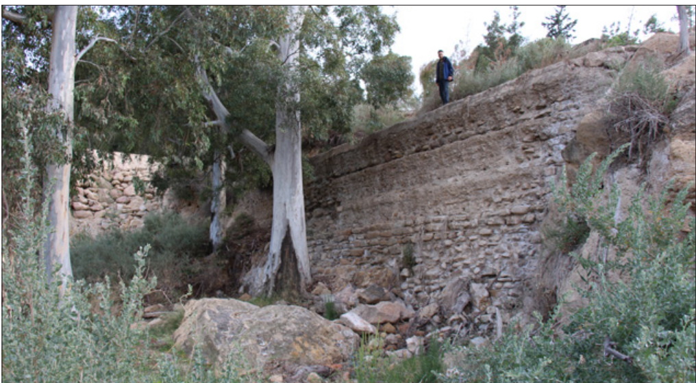
Figura 5.9: Restos del tapial que salva el desnivel entre la Rambla de Puerto de Garruchal y el canal principal de la boquera de Tiñosa.
