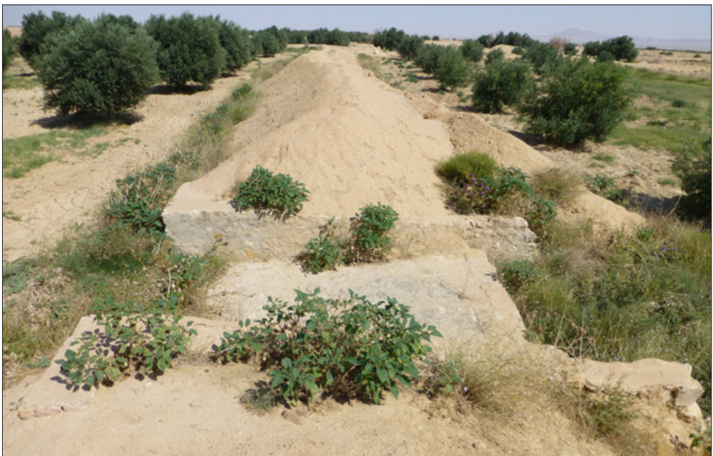
Figura 5.18: Sangrador o manfas en el mgoud de Ouled el Haj de Belkhir en Gafsa, Túnez. Fuente: Autor.
