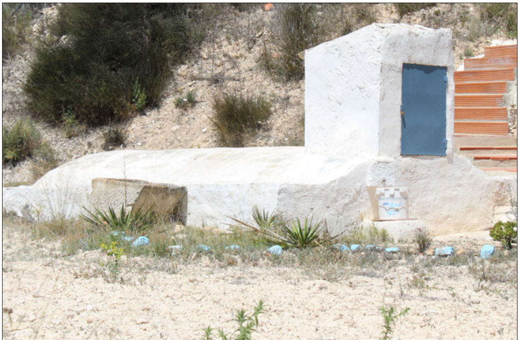
Figura 2.10: Aljibe para el almacenamiento de la escorrentía superficial en Agost, Alicante.
