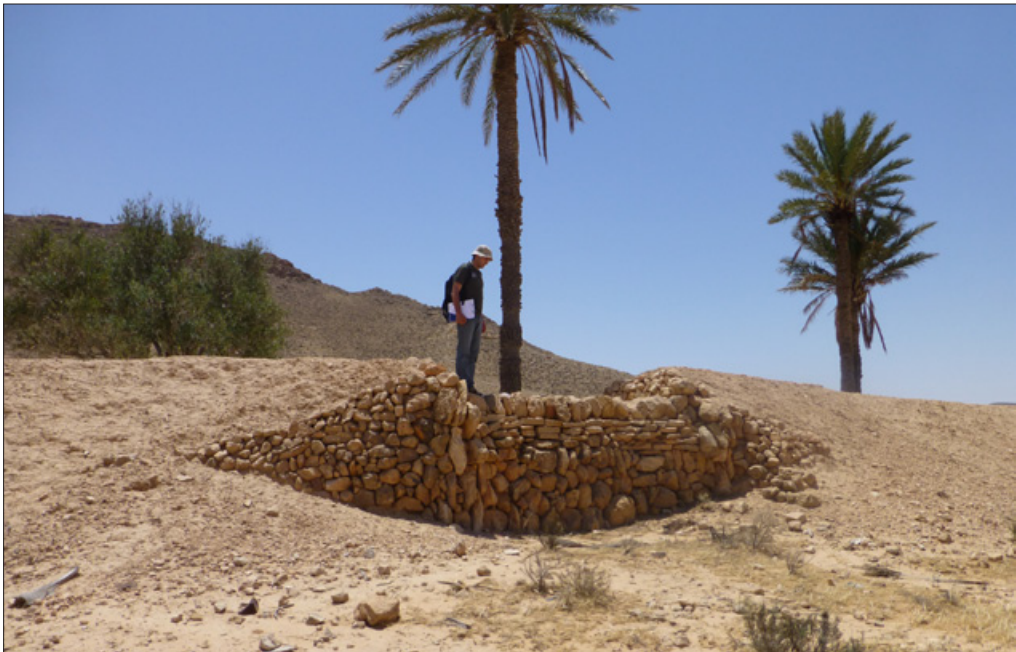
Figura 4.45: Manfas reforzado en una tabia en Medenine.
