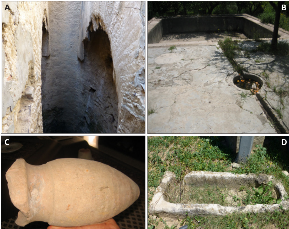
Figura 6.25: Elementos de un sistema de noria en Testour: A- El interior de una perforación donde había una noria; obsérvese la forma circular del pozo, el revestimiento de las paredes y los dos arcos paralelos que formaban la base de la noria. B- Balsa de acopio, con su decantador, por donde pasa la acequia que lleva el agua desde la noria. C- Arcaduz de barro cocido encontrado en el fondo de un pozo abandonado. D- Pila-abrevadero.
