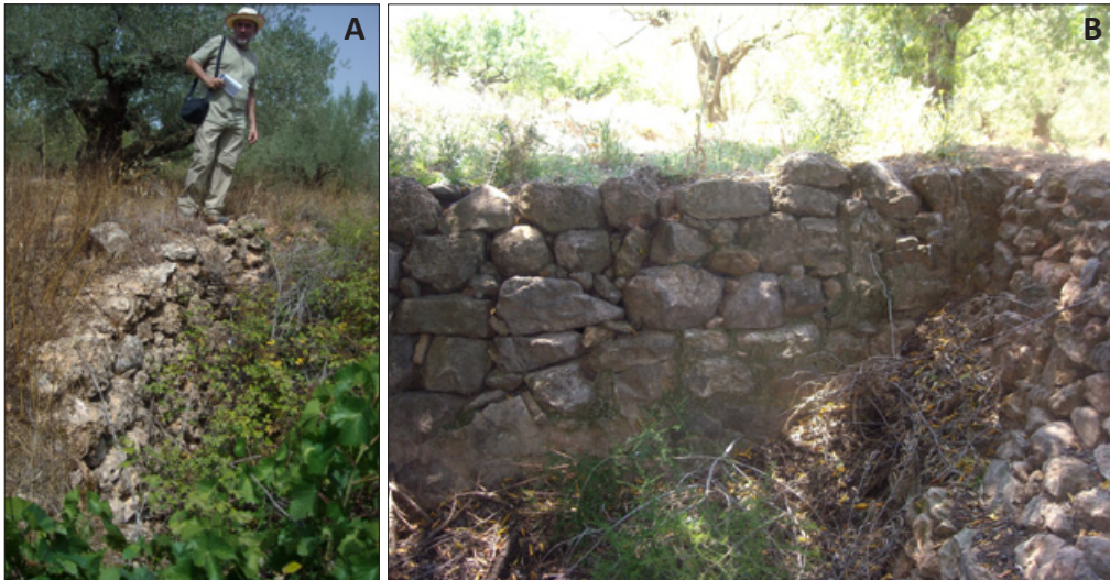
Figura 3.27: A-Salto curvo, que recoge la escorrentía de toda la parte superior de la cuenca y la concentra en la acequia; B-Salto recto, en el tramo final del sistema Viveros.
