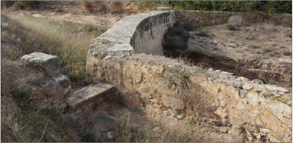
Figura 5.8: Azud de Guadalupe, en el barranco del Zoco o Cabezo Blanco, entre las pedanías de Espinardo y Guadalupe de Maciascoque (Murcia).
