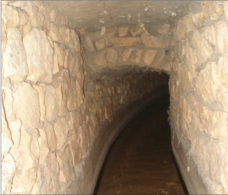
Figura 6.12: Interior de la galería de Oued Bou Haya.
