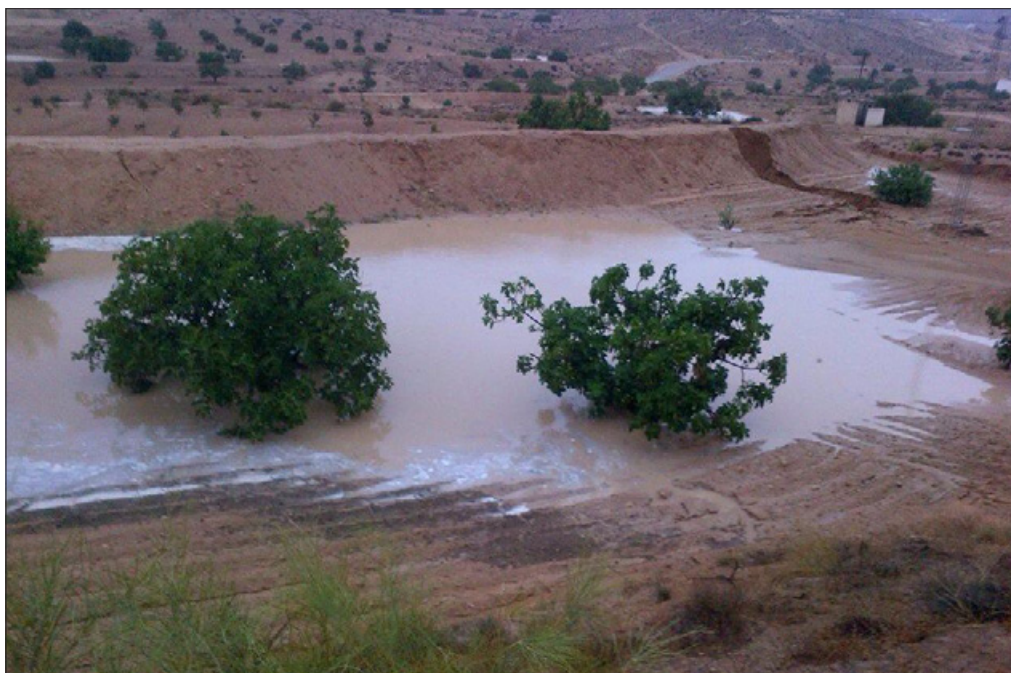
Figura 2.6: Tabia con agua embalsada tras un episodio de lluvias intensas en el sur tunecino. Fuente: Cortesía de M. Abbassi.
