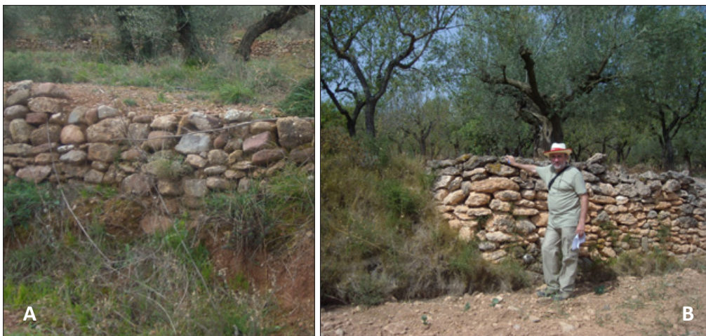
Figura 3.41: A-Pared-talud protegido con piedras sólo en su parte superior; B-Esquina de bancal reforzada, en el sistema Viveros.
