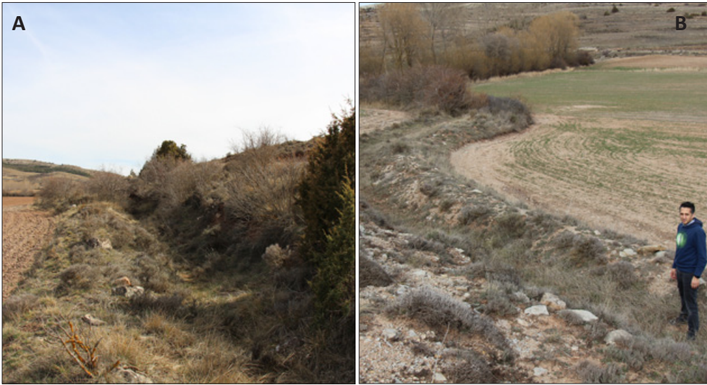
Figura 3.8-A y 3.8-B: Ejemplo de acequia recolectora a pie de ladera en la cuenca del Bco. de San Cristóbal (A). Ejemplo de acequia evacuadora, en la cuenca media del Bco. de San Cristóbal (B).
