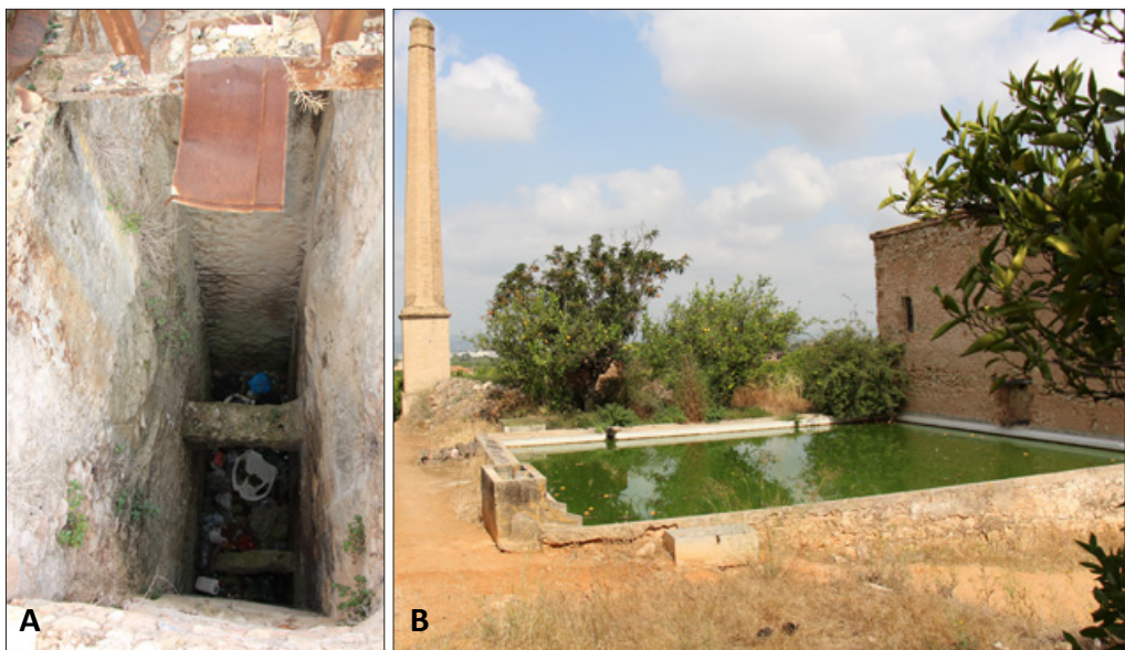
Figura 6.34: A- Interior de un pozo de la noria de Casa de Boquera en Alzira. B- Balsa y chimenea de la noria de Casa de Cogollos, en Carcaixent.
