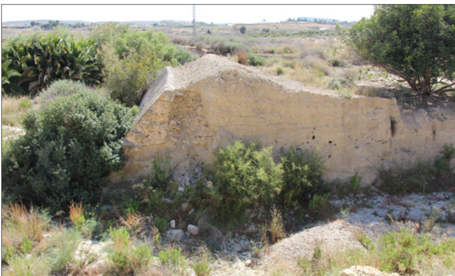
Figura 5.41: Parat de Fontcalent. Se observa la acumulación de detríticos ocasionada por el parat y el encajamiento actual del barranco.
