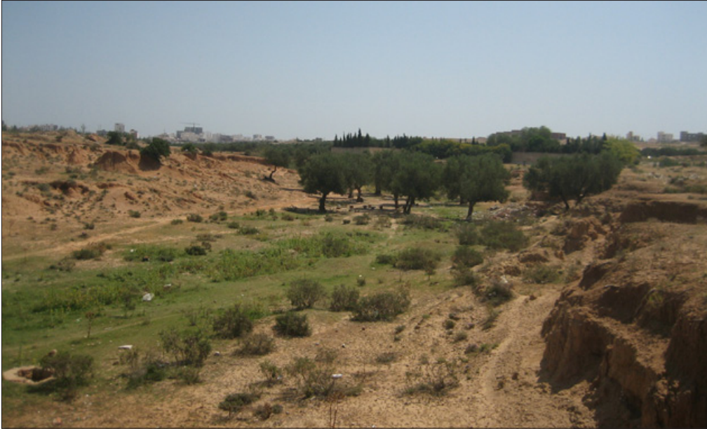
Figura 6.6: Cauce del Oued Kharroub. Obsérvese una de las lumbreras de Ain Oued Kharroub.
