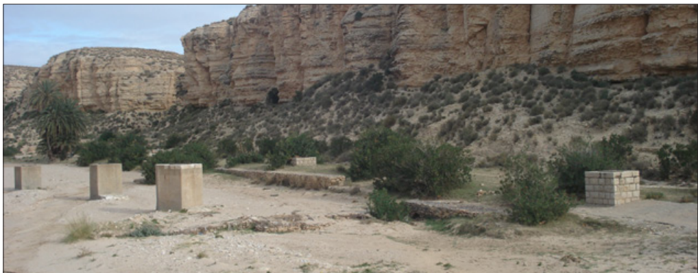
Figura 6.11: Oued Sbeitla. Obsérvese la bifurcación, que se adentra en la Oued , de la galería de Ain Oued Sbeitla con sus lumbreras pentagonales aproadas a la dirección del flujo.
