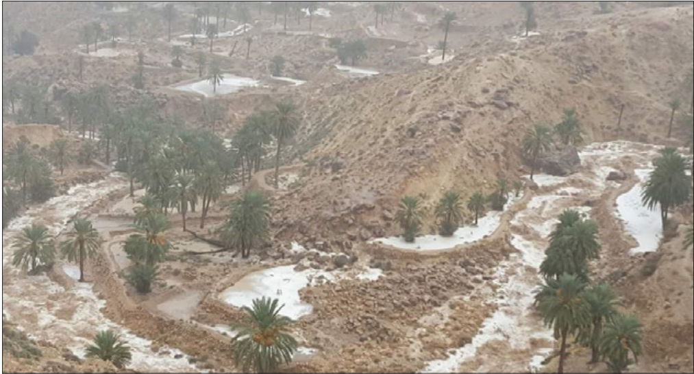
Figura 2.11: Mgoud en pleno funcionamiento en Dkhilet Toujane, Gabes.
