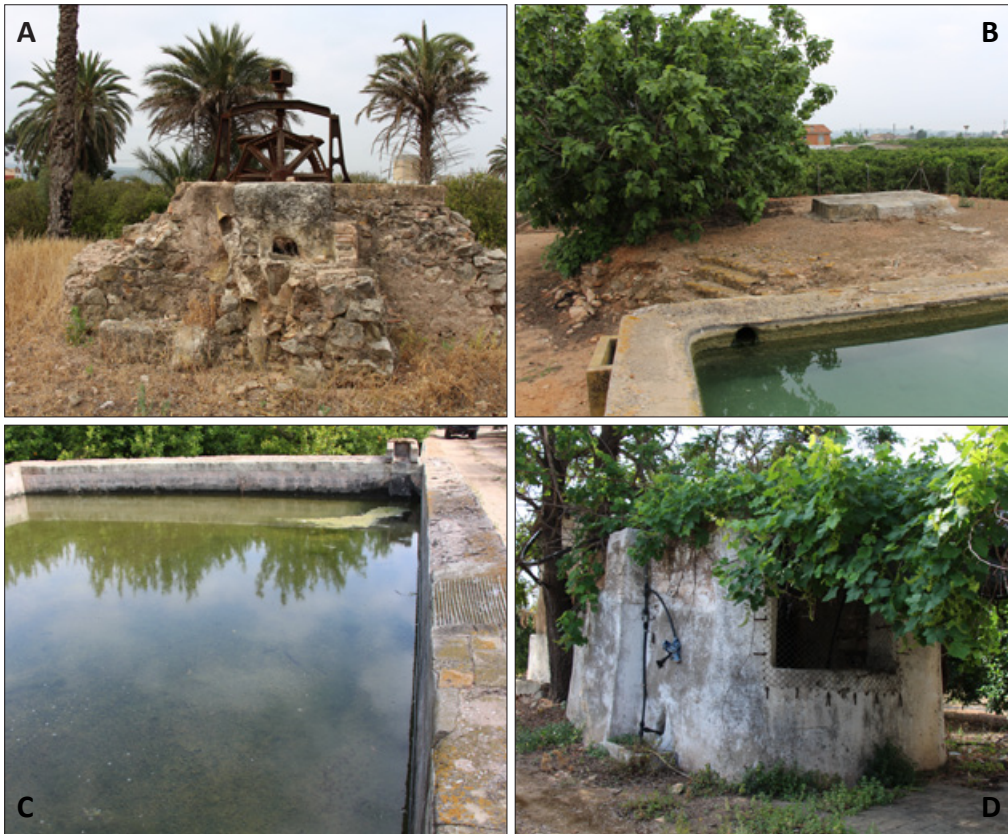
Figura 6.33: A- Noria de hierro fundido ubicada en el Huerto de Casa de la Boquera, Alzira. B- Balsa y era con las escaleras de la noria de Casa de Agustín, en el Camí de Bernabé, en Alzira. C- Balsa de la Noria de Casa de Blanc, en Carcaixent. Obsérvese la losa de lavar fijada en el lado de la balsa más próximo a la vivienda. D- Pozo y resto de la estructura que sostenía la noria de la Casa de Noguera, en Carcaixent. Fijese que es de la tipología “eje elevado”, diferente a la tipología más extendida en el sureste español, de “eje corto”.
