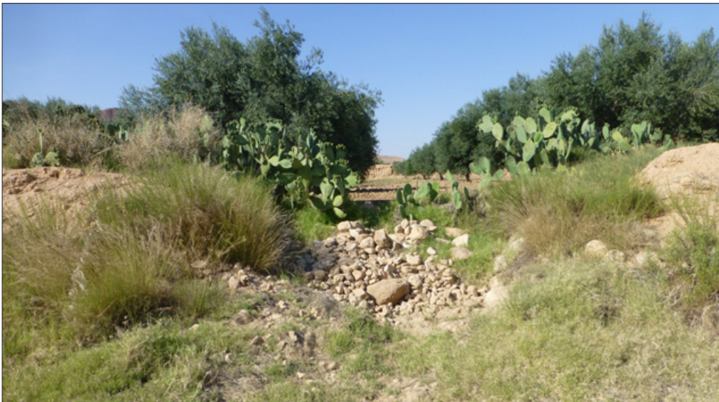
Figura 5.17: Entrada del mgoud de Belgasem Ben Ali en los campos de olivo. Obsérvese la vegetación y la acumulación de piedras como una medida para disminuir la velocidad de la corriente de agua con el fin de proteger los campos de la erosión. Belkhir, en Gafsa, Túnez.
