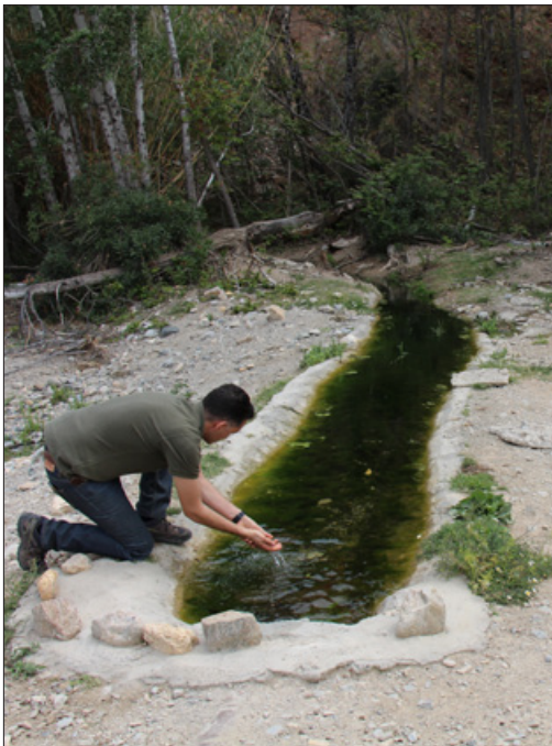
Figura 6.14: Abrevadero e inicio del sistema de riego de la Zanja del Burro o de los Corella.
