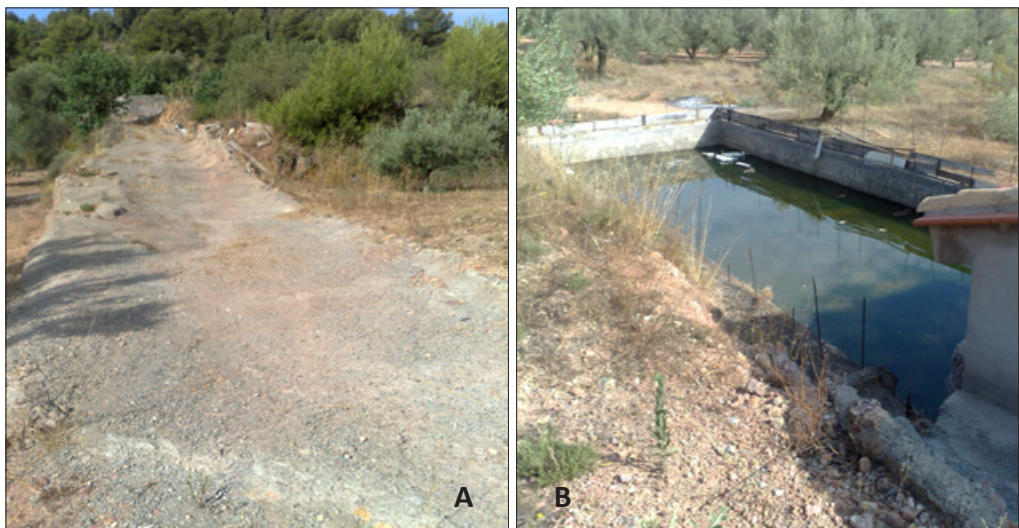
Figura 3.32: Sistema de aprovechamiento de aguas de escorrentía. A-El camino que conduce el agua; B-El depósito de agua.
