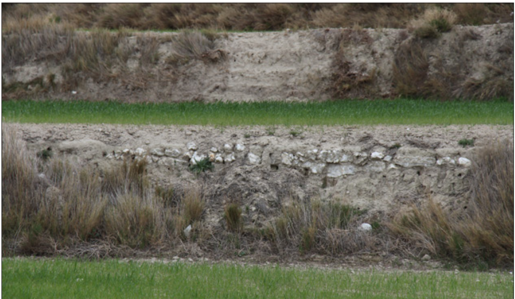
Figura 4.12: Detalle de talud reforzado con bloques de yesos en un bancal con desagüe frontal. . Fuente: Autor.
