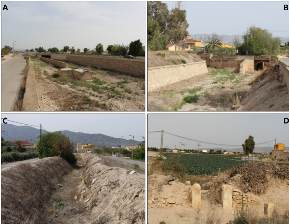
Figura 5.5: A) La bifurcación de la Rambla de Tiata entre el canal de los brazales de las Zahurdas, del Pozo o la Cuadrilla (izquierda) y el canal de los de Enmedio, Cañaveral, Nuevo, etc. (derecha). B) Bifurcación entre la Acequia de Enmedio (derecha), y las de Cañaveral y Canal Nuevo (izquierda). C) Acequia de Cañaveral, con márgenes sobreelevados de tierra. D) Tajadera en la Acequia de Cañaveral.
