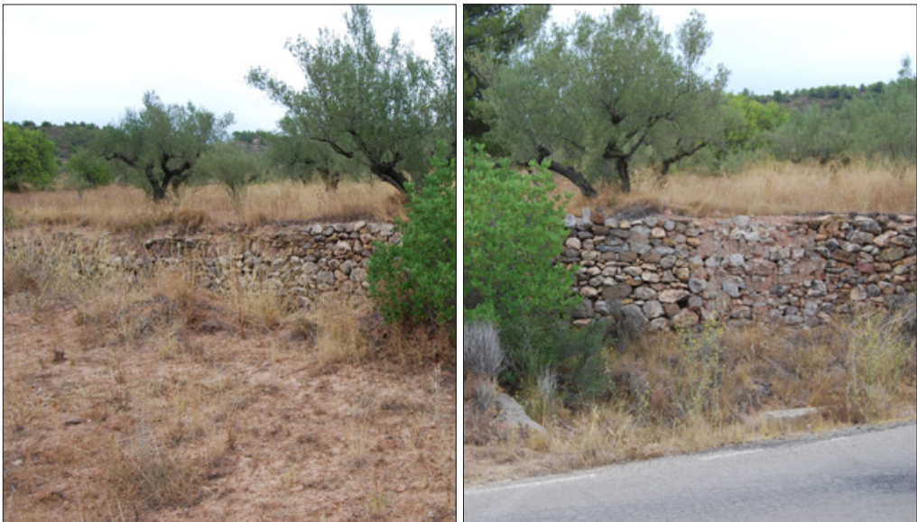
Figura 3.30: Esquina de bancale reforzada, en la parte baja del sistema Valero. Fuente: Autor.
