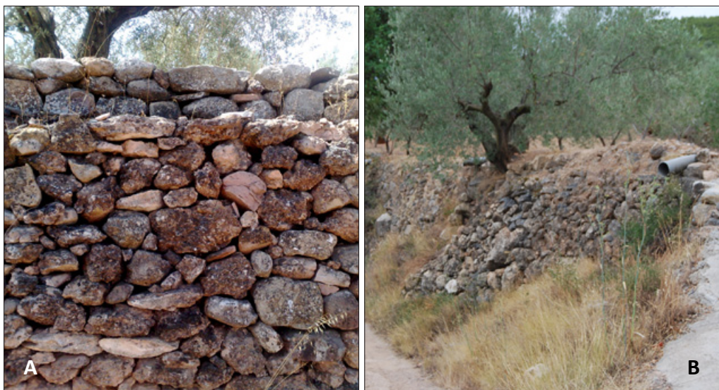
Figura 3.43: A-Pared que se sobreeleva sobre la superficie del bancal; B-Pared en la que se han dispuesto desagües.
