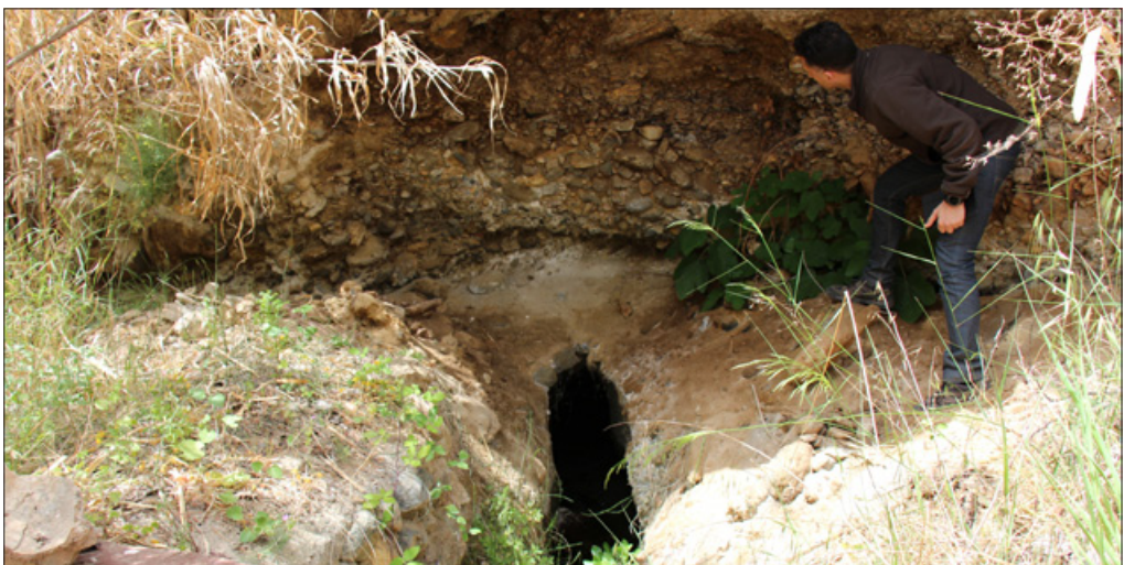
Figura 6.9: Bocamina de la Zanja de la Huerta de Judas. Obsérvese los materiales de depósito cuaternario de la terraza fluvial.
