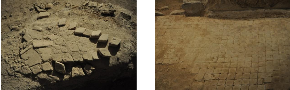
Fig. 19. Pavimentos de carácter hidráulico formados por ladrillos romboidales aparecidos en la Domus S-Palau de L'Almirall (VAL_12) ( Valentia ) (izq.) y la Domus dels Peixos (SAG_1) ( Saguntum ) (dcha.).
