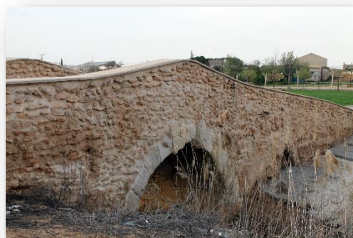
Ilustración 15: Puente Romano en la actualidad
