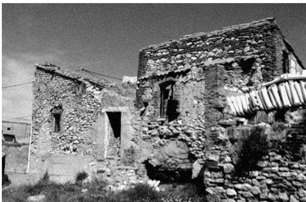
Detalle de la fábrica en marzo de 2002 por la parte que daba a la calle Huerto. Cada una de las ventanas se correspondía en su interior con un torno de rueda o pie. Se aprecia el alto grado de deterioro que sufrió este antiguo obrador. Fuente Vicente Gimeno Peris.
