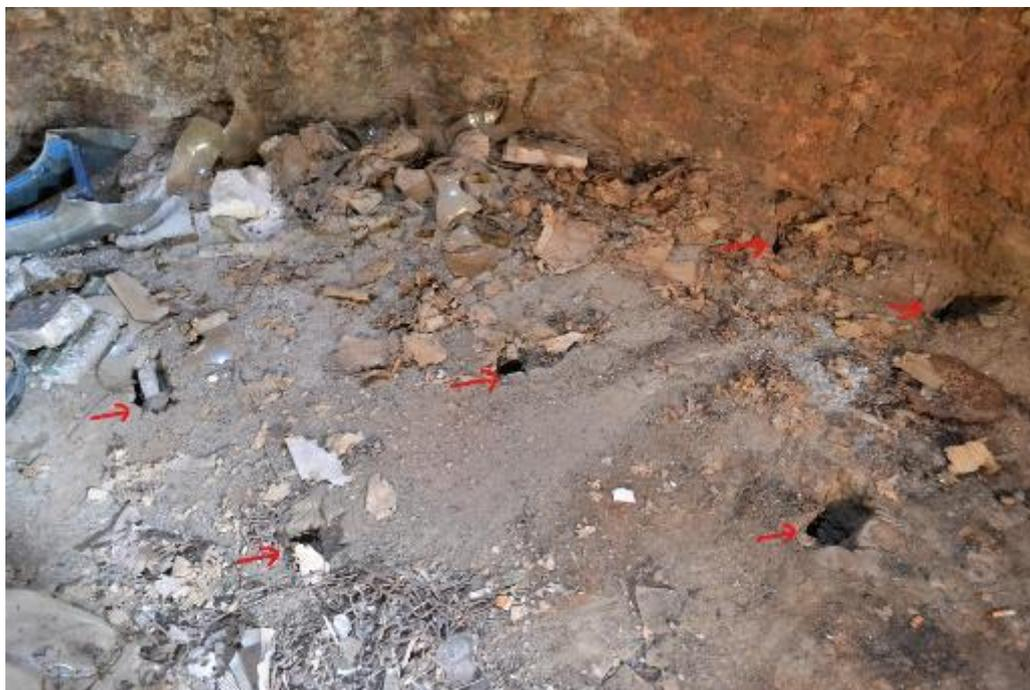
13.1.5. Detalle de la cubierta del horno en 2012. Hemos señalado en negro la bravera y en rojo uno de los ojales o respiraderos que servían para el control del fuego. Fuente procedente del dpto. de Urbanismo de Manises.
