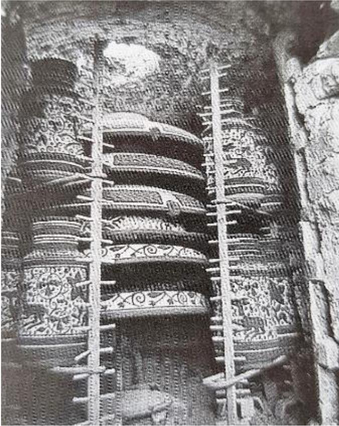
Fig.41. Horno *moruno* de reflejo metálico de la fábrica la Ceramo (apr.1985). Imagen reproducida del libro *La Ceràmica de Reflex Metàlic a Manises* (1850-1960). Museu de la Diputació de València, p.68.
