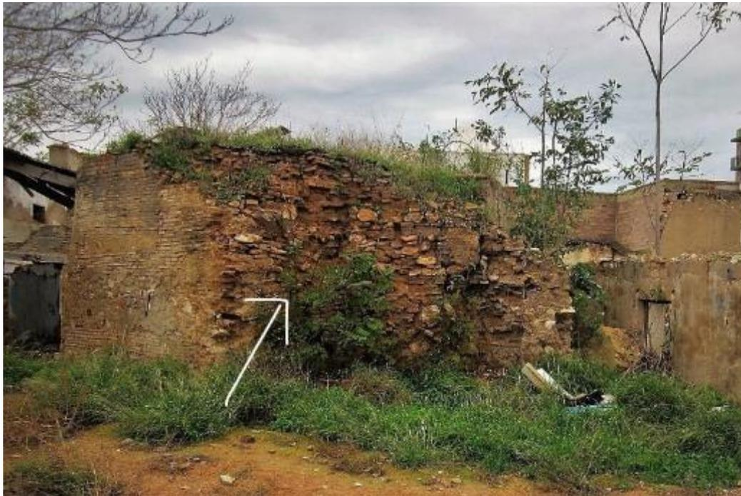
13.1.3. Detalle de la bóveda del horno en 2012. Se observa la bravera o chimenea en el centro y los ojales o respiraderos repartidos en varias hileras para el control del fuego. Fuente procedente del dpto. de Urbanismo de Manises.
