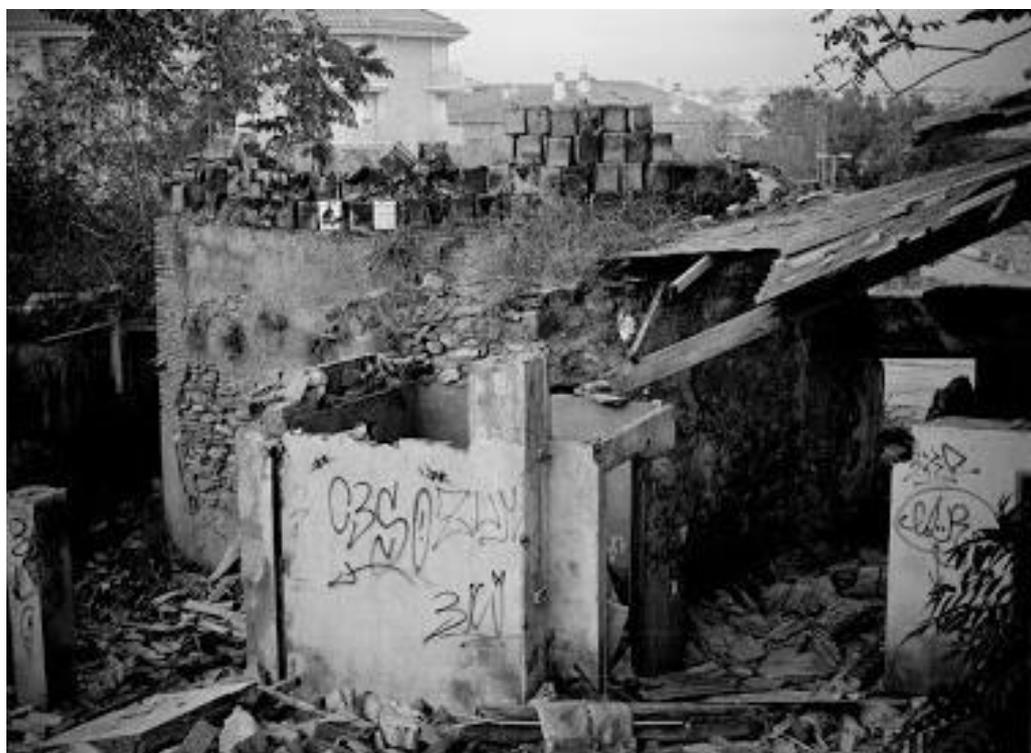
13.1.2. Lateral norte de la estructura exterior del horno en 2012. Hemos señalado con una flecha donde sufrió la agresión por la demolición del horno gemelo al que tangencialmente iba unido. Fuente procedente del dpto. de Urbanismo de Manises.
