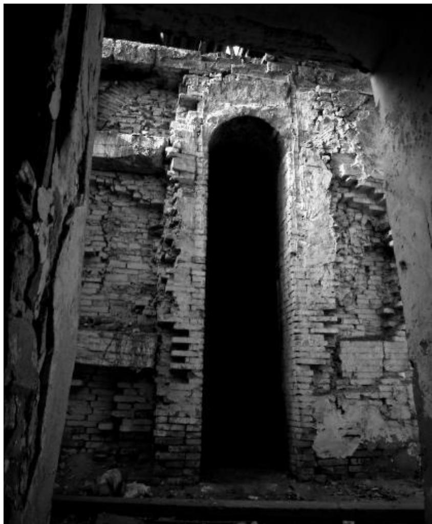
Interior de la fábrica en 2009. Se observa una pared realizada con cisternas rotas. Fuente V. Gimeno.
