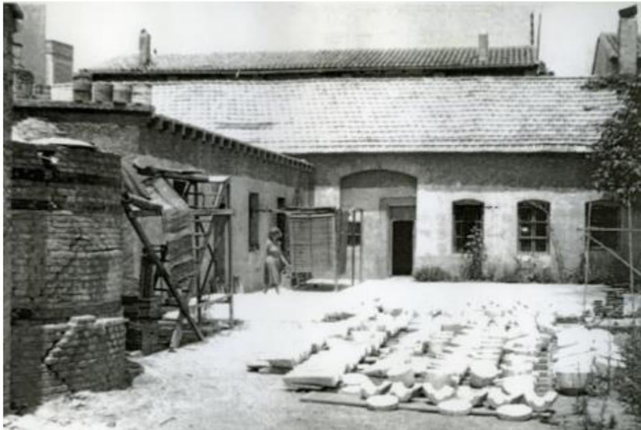
*Fig.32.* Patio de un obrador cerámico con moldes secándose al sol. Manises década de los 70 del siglo XX. A la izquierda se observa parte de la estructura de un horno *moruno*. Imagen cedida por el Archivo Municipal de Manises. Fondos Carlos Sanchis.
