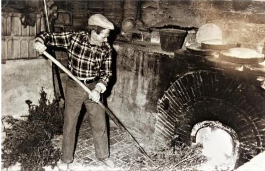
Fig.36 y 37. Operarios en el piso inferior de un horno moruno. Se puede observar la caldera y también el murete o banco denominado *sagen*. En la imagen superior echando a la caldera garbas de leña. En la inferior alimentando la caldera del horno con serrín. Manises año 1969-1970. Imágenes cedidas por el Archivo Municipal de Manises.
