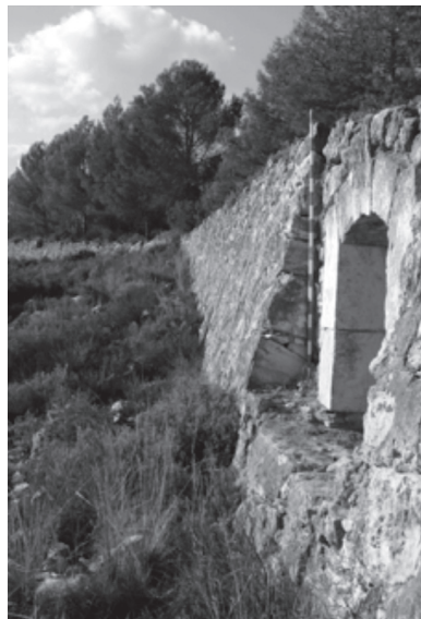
Fig. 9.- Detalle de la tajea del tramo construido en la recta R.19 (entre K.3 y K.4) (jalón= 1 m).
