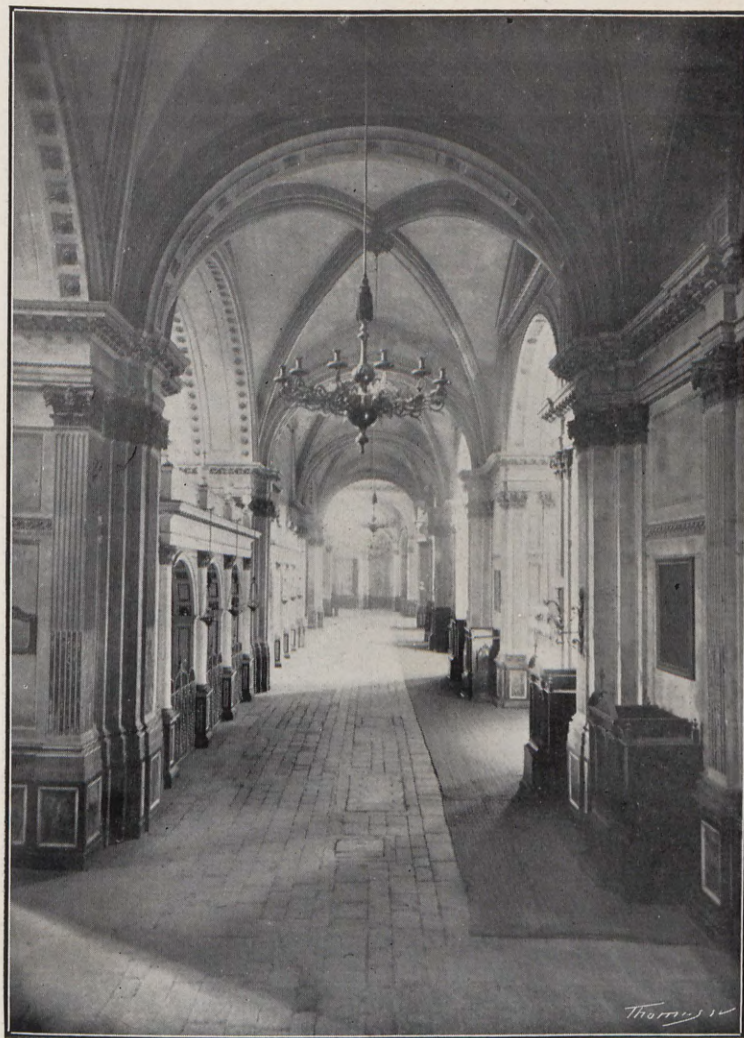
2.—Actual nave lateral izquierda de la Catedral.
