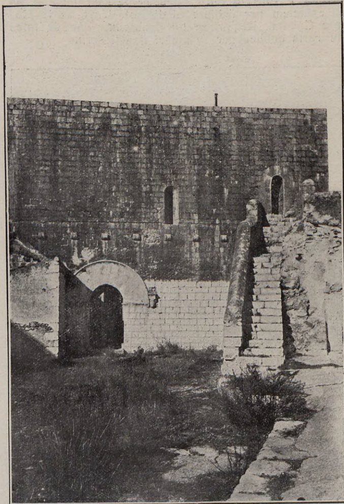
77.—CASTILLO DE PEÑÍSCOLA Fachada y portal de la Basílica
