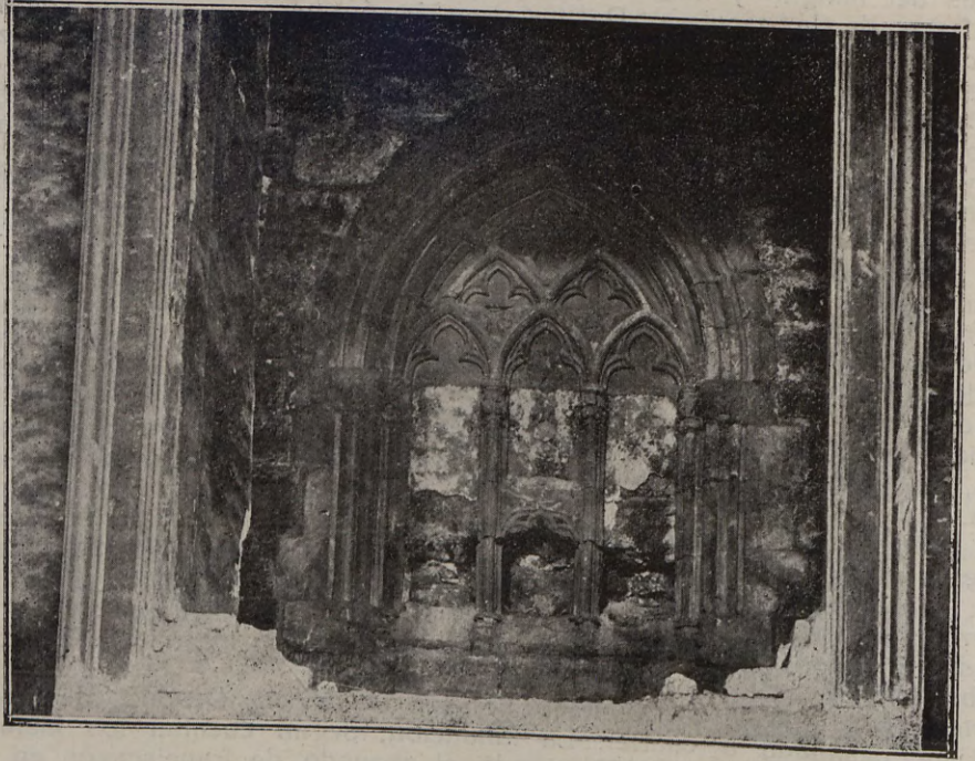
37.—MORELLA.—Iglesia de San Francisco. Uno de los ventanales del ábside
