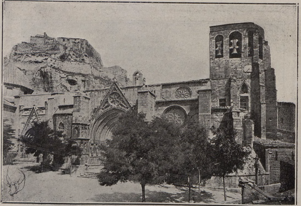
17.—MORELLA.—Fachada de la iglesia de Santa María la Mayor
