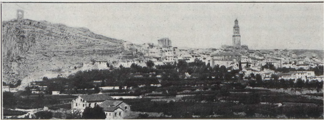
Campanario visto por el S. E.
