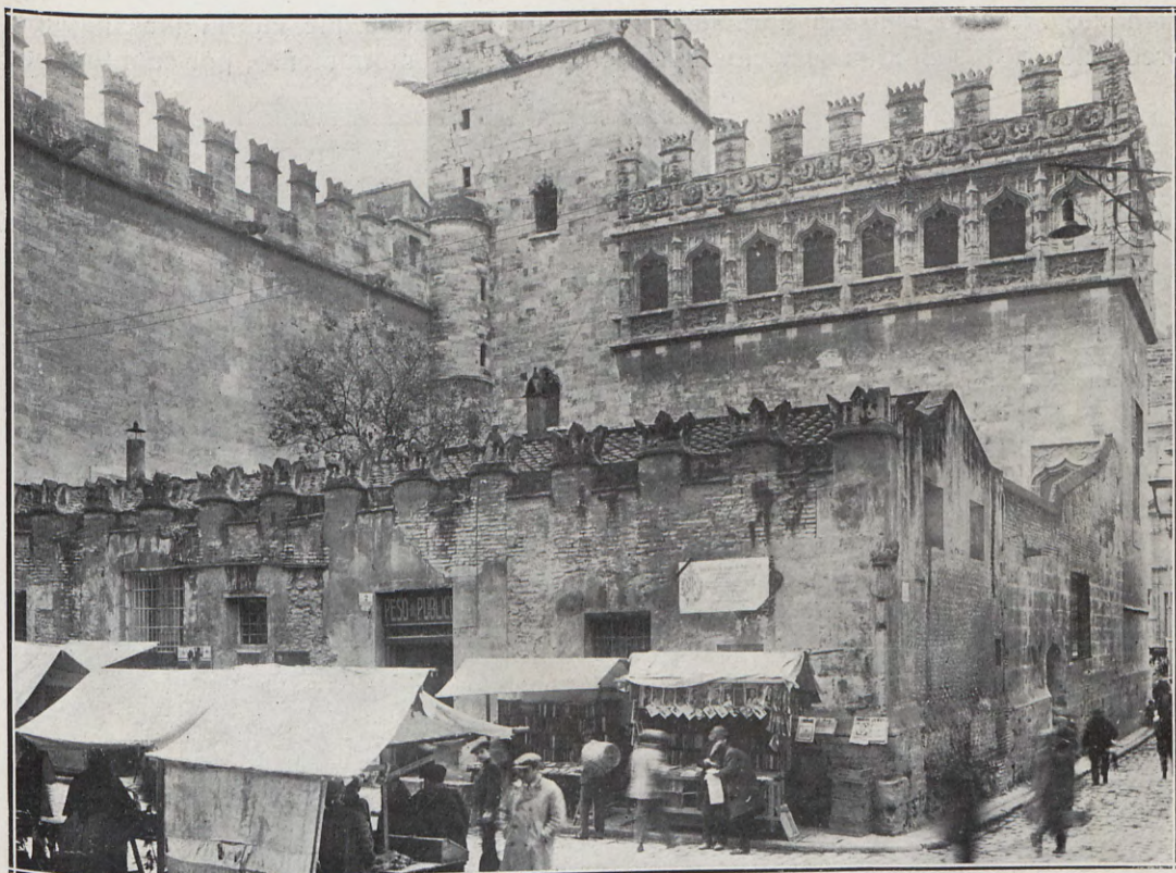
Aspecto exterior que actualmente presentan los muros de cerramiento del patio de los naranjos.
