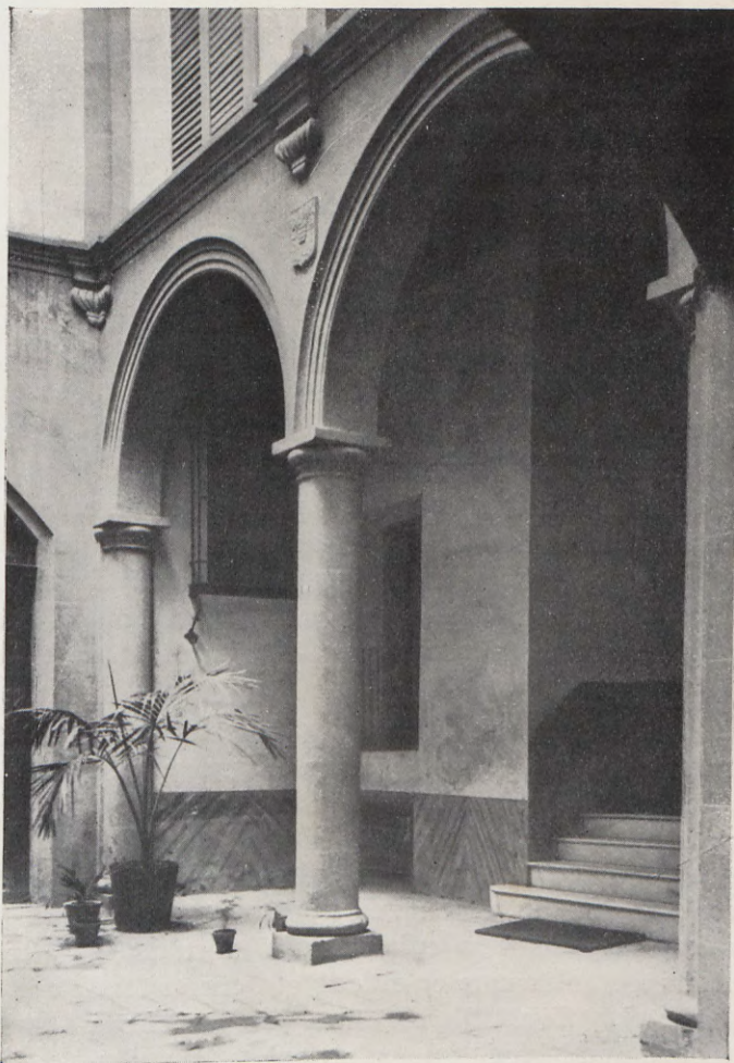
6.—Patio porticado de la casa núm. 3 de la calle de la Concordia.
