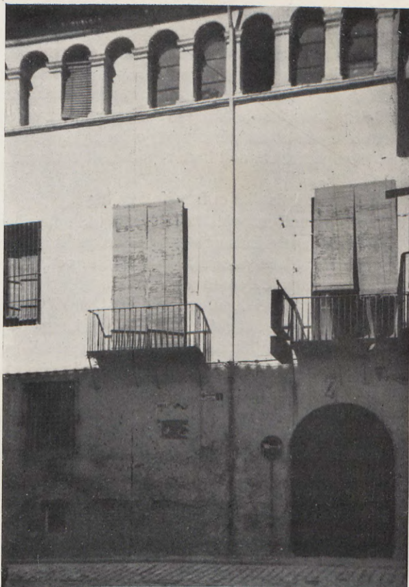
11. - Fachada de la casa núm. 4 de la calle de En Sendra.
