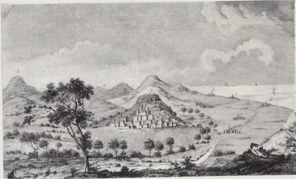
FIG. 4.—Vista de la villa de Onda, según las «Observaciones», de Cavanilles.
