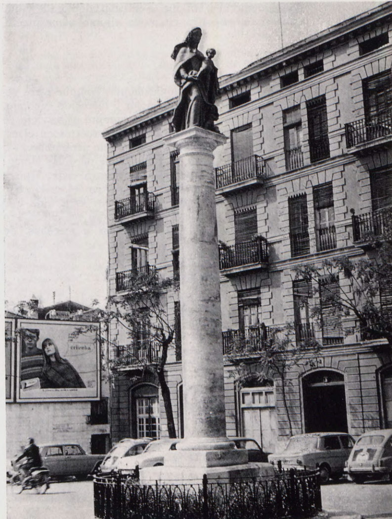
Imagen en bronce de la Virgen del Carmen, obra del escultor Ramón Mateu, instalada en la plaza del Portal Nuevo.
