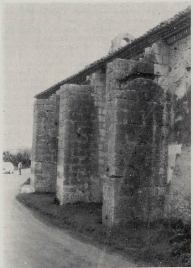
Contrafuertes laterales del templo de Ternils
