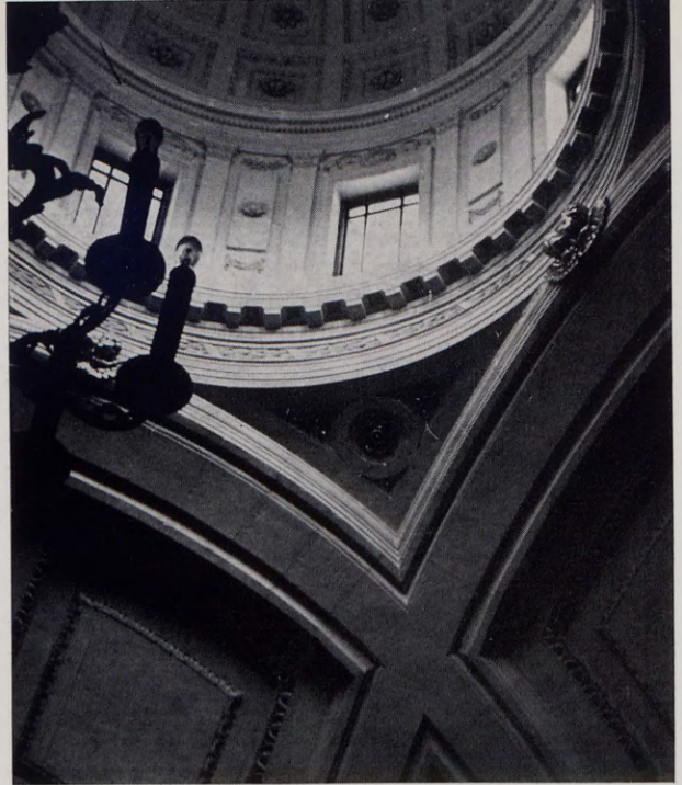
Elche. Iglesia de Santa María. Capilla de la Comunión. Sistema de cubiertas.
