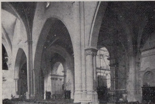
Nave central, durante las obras, de la Catedral de Valencia
