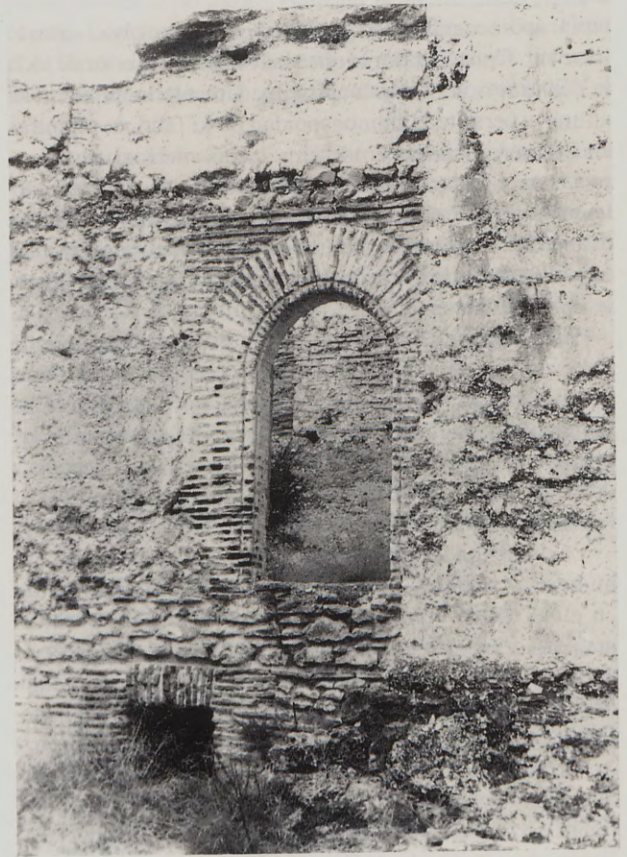
Detalle del vano del salón noroeste recayente al patio inferior
