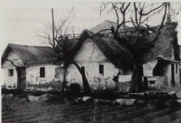
Grupo de barracas en estado de deterioro en la huerta de La Torre junto al cauce nuevo del Turia
