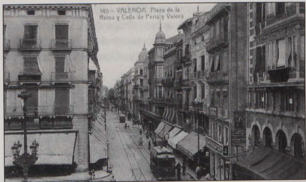
Fig. 2. Vista retrospectiva de la Plaza de la Reina con el edificio de Lucas García en primer término y de la calle de Peris y Valero, posterior de la Paz. Valencia. (Fototipia Thomas, Barcelona, de hacia 1910).
