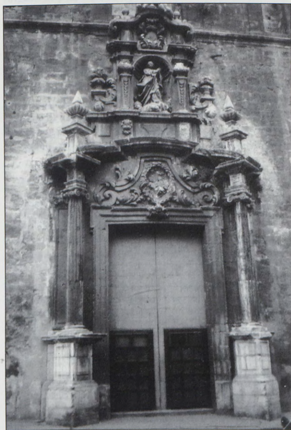
Portada barroca lateral de la Paja. Iglesia de los Santos Juanes. Valencia.
