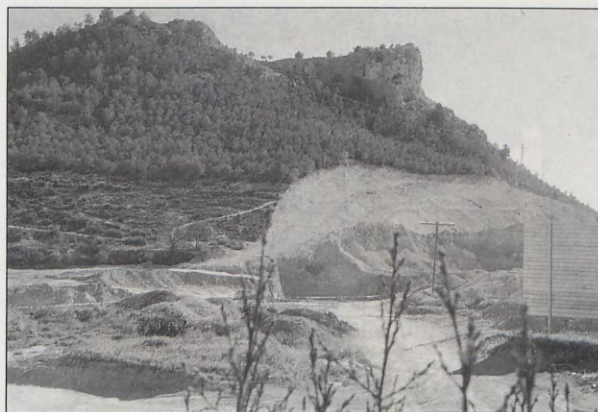
Variante de la carretera N-340 al paso por Jijona, entre las ermitas de San Sebastián y Santa Bárbara
