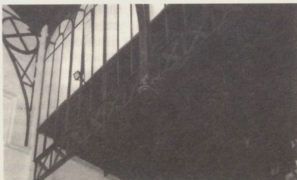
Fig. 1- Interior del Salón de Racionistas. Unión de los soportes laterales con los arcos centrales.
