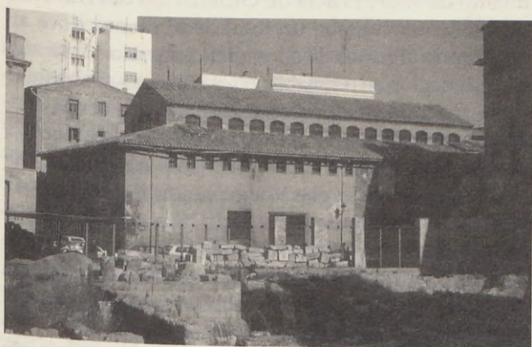
Vista del Almodín antes de su restauración
