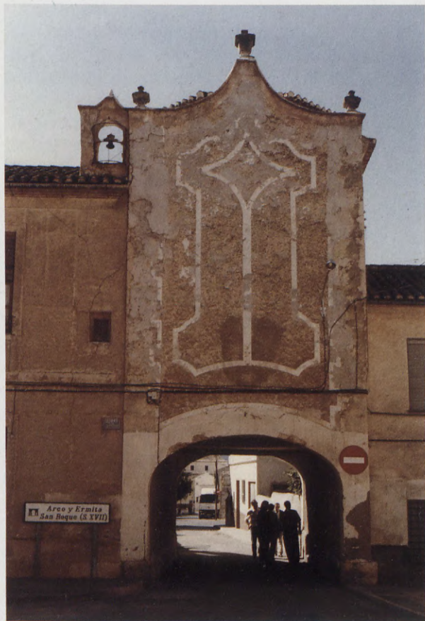
Fig. 2.- JUMILLA. Ermita de San Roque, sobre la denominada Puerta de Granada. Fachada septentrional. Año 1792. (Foto Javier Delicado, enero de 1997)
