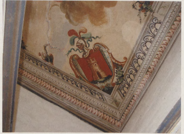
FOTO 27.- Detall de la pintura del sostre de l'escala on apareix en un cantó l'escut nobiliari dels Marau.
