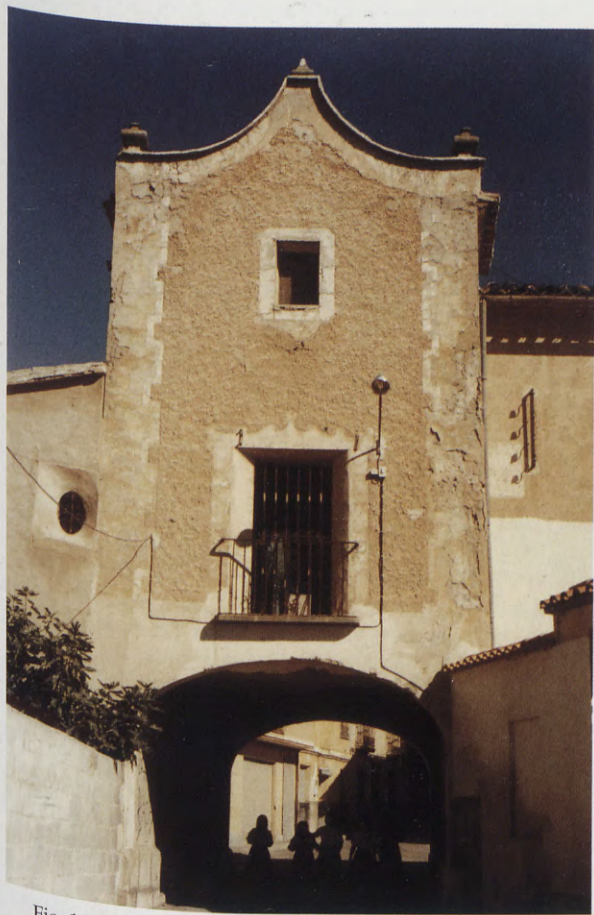
Fig. 1.- JUMILLA. Ermita de San Roque, sobre la denominada Puerta de Granada. Fachada meridional. Año 1792. Edificio neoclásico acaso del maestro de obras Pedro Gilabert. (Foto Javier Delicado, enero de 1997)
