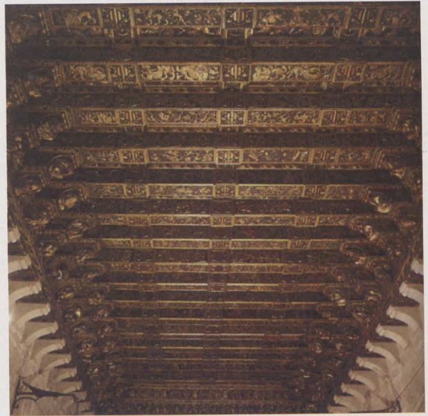
Fig. 6.– Artesonado procedente de la Sala Dorada de la Casa de la Ciudad ubicado actualmente en la Lonja.
