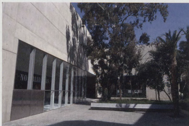
Fig. 7.- MuVIM. Patio exterior
