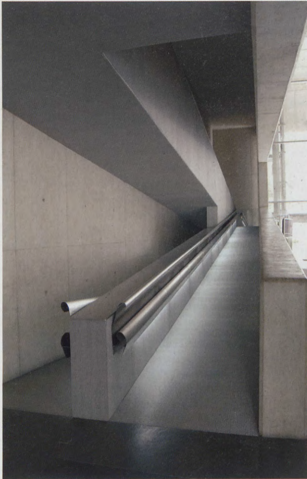
Fig. 4.- MuVIM. Edificio dotado con rampas accesibles
