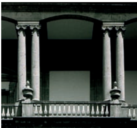
Fig. 10.-Columnas del Patio Palacio de Minería.
