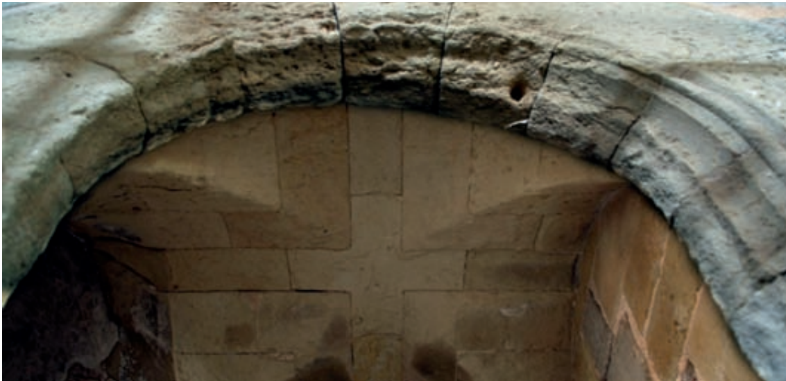
Fig. 13.-Bóveda de arista del púlpito del refectorio del monasterio de Santa María de la Valldigna en Valencia.
