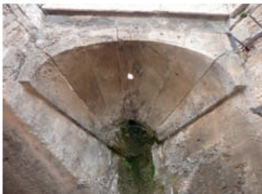
Fig. 23.-Pechina carpanel con trompillo avenerado. Puente de la Trinidad. Valencia.
