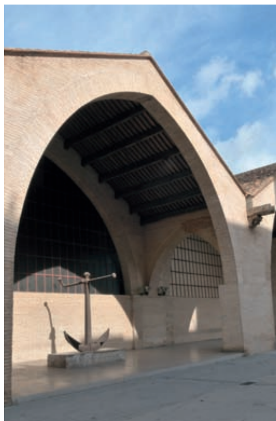
Fig. 2.- Un aspecto de la fachada porticada de las atarazanas en la que resulta visible una de las gárgolas con el escudo de la Ciudad. Fotog. de Josep Manel Vert.
