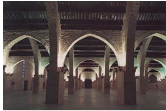
Fig. 9.- Vista de las naves trasversales. Fotog. de Josep Manel Vert.
