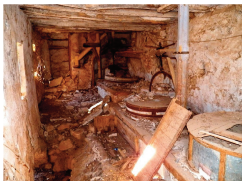
Figura 5. Sala de molienda del Molino Nuevo de Orrios.
