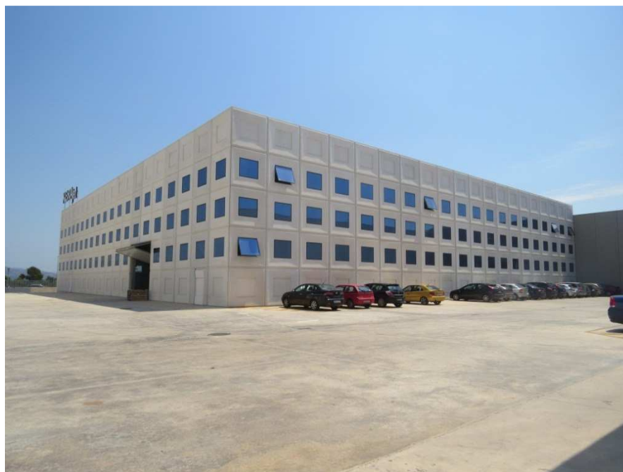
Figura 37 – Foto de Kerajet localizada no município de Almazora na Província de Castellón (Espanha) Autora: Keity Kristiny Vieira Isoppo, 2015.
