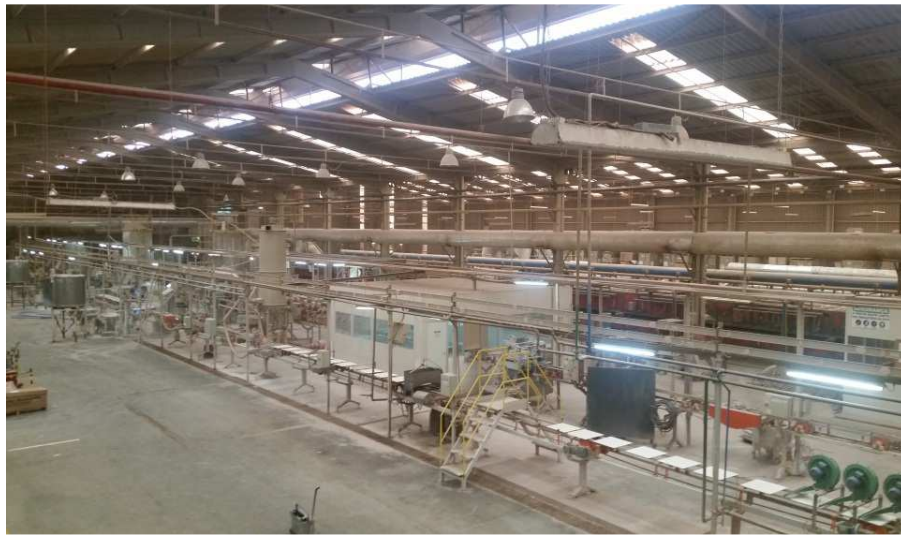
Figura 26 – Foto da Linha de Esmaltação da Angelgres. Pode-se perceber a sala climatizada que abriga a impressora digital em combinação aos métodos tradicionais de esmaltação
