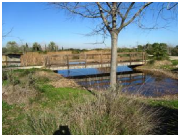
Figura 26: Puente sobre laguna.
