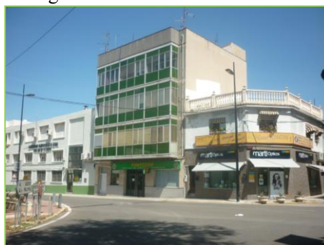
Figura 4.9. -Sede de la Cooperativa Agrícola y Caja Rural Nuestra Señora de la Fuente en Villalonga de la Safor
