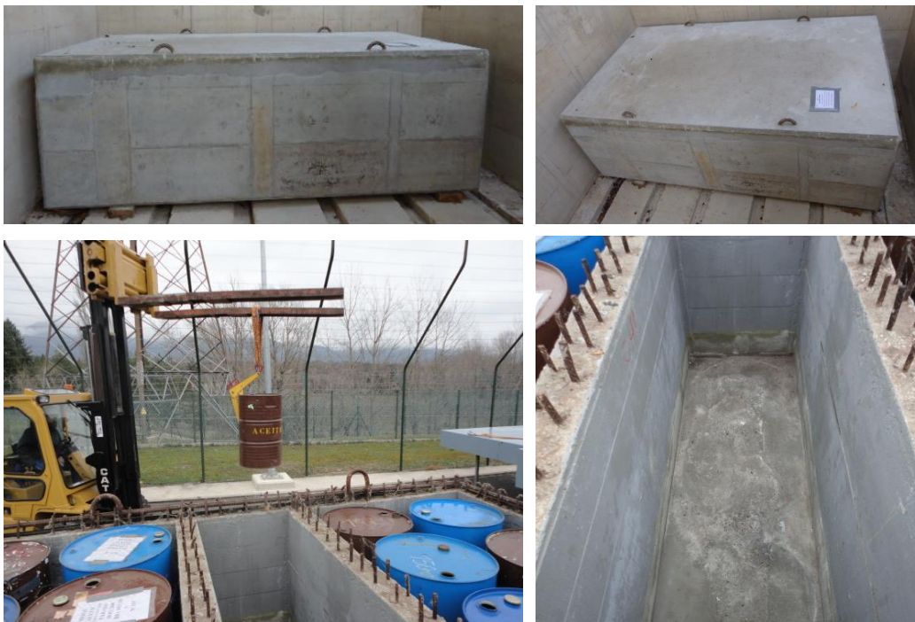
Figura 13.1. Imagen del cofre sellado de hormigón de C. N. Santa María de Garoña durante su acondicionamiento en los años 80.
