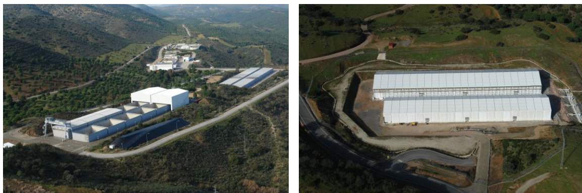
Figura 1.1. Centro de Almacenamiento El Cabril: área de almacenamiento de RBMA (izquierda) y RBBA (derecha)
