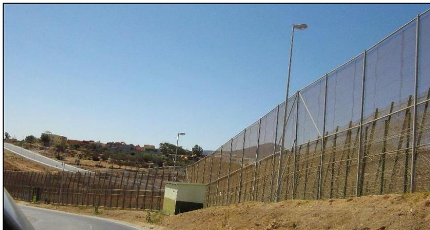
Fotografía 111 Torres, S. (13 de agosto de 2018, valla de Melilla). La valla se inclina 10º hacia el lado marroquí para evitar ser escalado. En la fotografía, se aprecia la inclinación de la valla.
