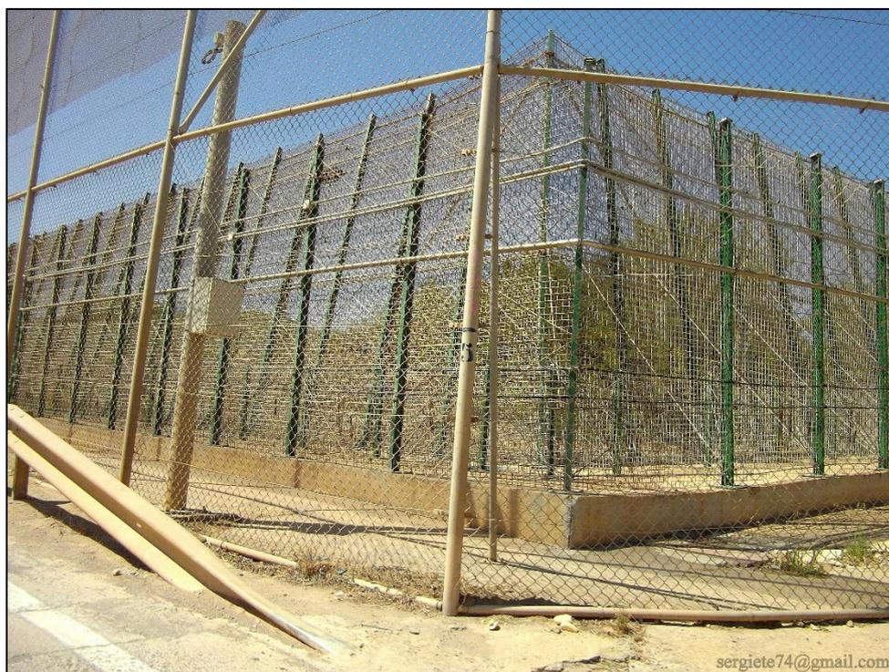
Fotografía 110 Torres, S. (15 de agosto de 2014, valla de Melilla). Detalle de la valla a través de la cual se puede apreciar la maraña de red de alambre.
