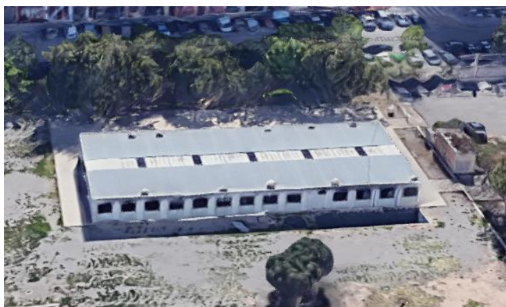
Figura 26. Aulas prefabricadas del IES Montesclaros. Fuente: Google Maps (s.f.e).
