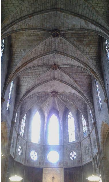
Fig. 6. Monestir de Santa Maria de Pedralbes. Interior de l'església. Sostre amb cobertes de volta de creueria i capçalera poligonal.
