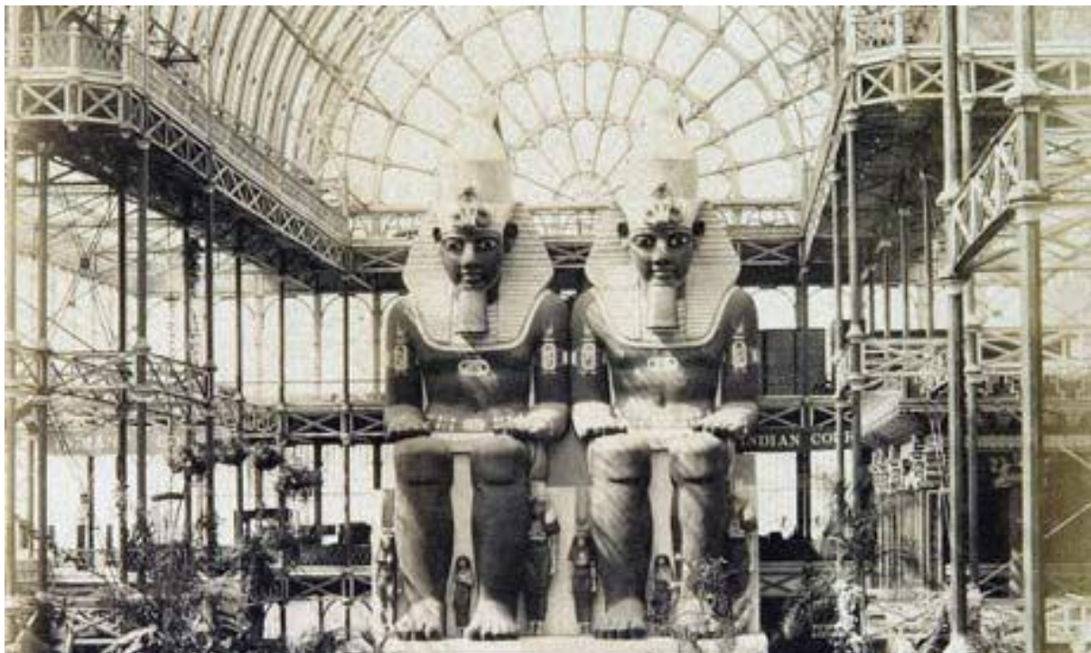
Fig. 10- Construcción del pabellón egipcio de la Great Exhibition of the Works of Industry of all Nations de 1851.
