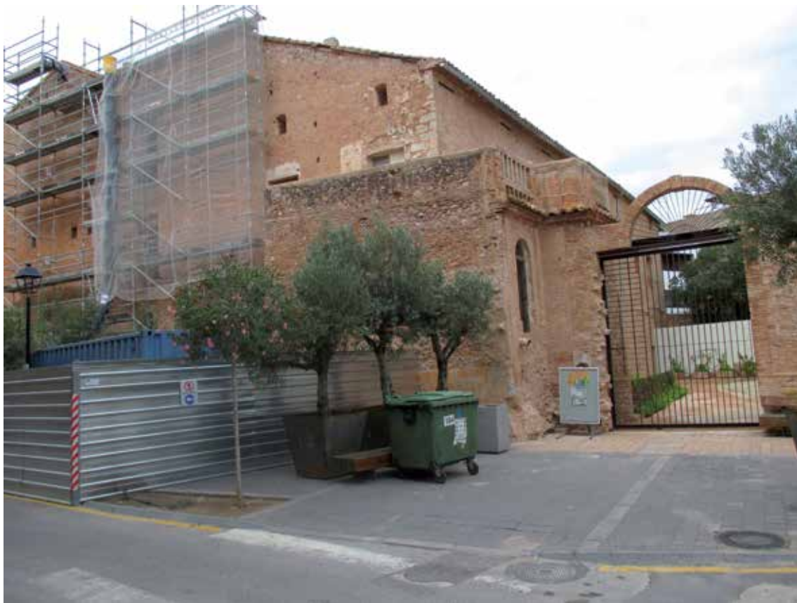
Fig. 20.- Betxí (Castellón). Palacio de los Almirante o de los condes de Arizo . En fase de rehabilitación. (Foto: Javier Delicado, agosto de 2018).
