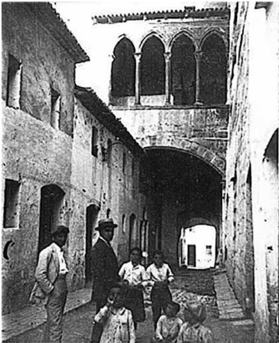
Fig. 15.- Oliva (Valencia). Palacio condal de los Centelles o de los duques de Osuna . Del siglo XVI, fue demolido durante la primera mitad del siglo XX. Vista de la denominada "calle del Palacio" que atravesaba por el centro la mansión solariega. (Foto de hacia 1920).
