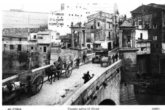
ALCIRA Puente sobre el Júcar DURÁ
