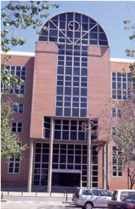
Fig. 23.- Valencia. Edificio construido como Nuevas Oficinas Municipales , acogió la Delegación de Urbanismo, databa de los años 1985-1986 y fue derribado en 2015. (Foto: Javier Delicado, 2005)
