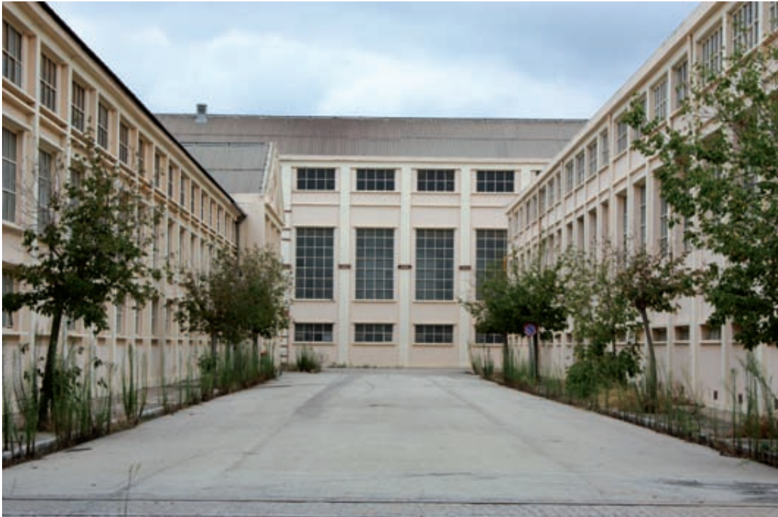
Fig. 10– Calle interior que separa los talleres de monturas y de tratamientos térmicos.
