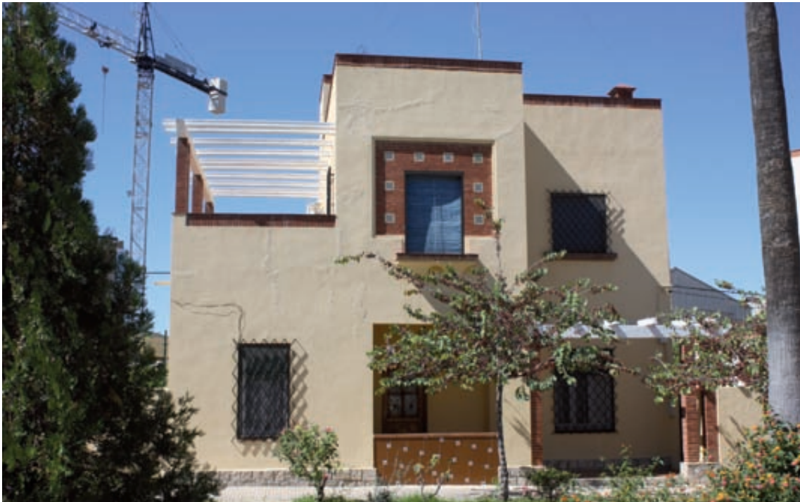
Fig. 4– Vivienda para ingenieros con cubierta plana.
