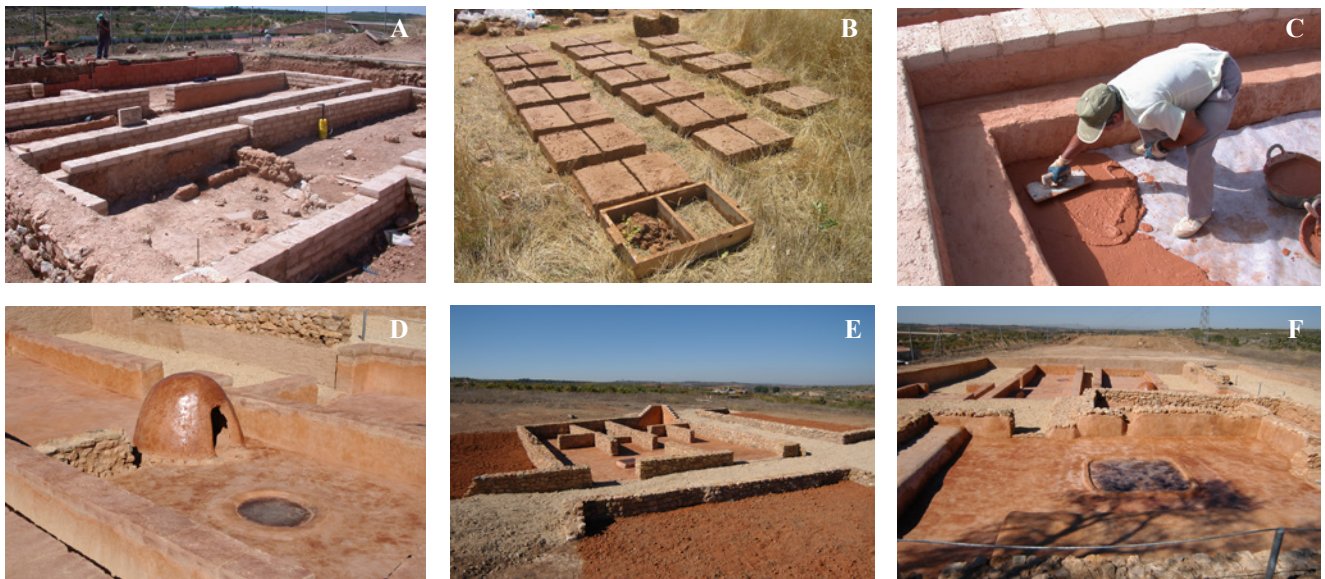
Fig. 14.3. A, Zona B en proceso de restauración (año 2004). B, Fabricación de adobes (año 2004). C, Haciendo un suelo en la Zona B (año 2004). D, Horno y hogar restaurados en Zona B (año 2004). E, Vista final de la Zona A (año 2004). F, Vista final de la Zona B desde el E (año 2004) (fotografías A. Moreno y G. Pérez).
