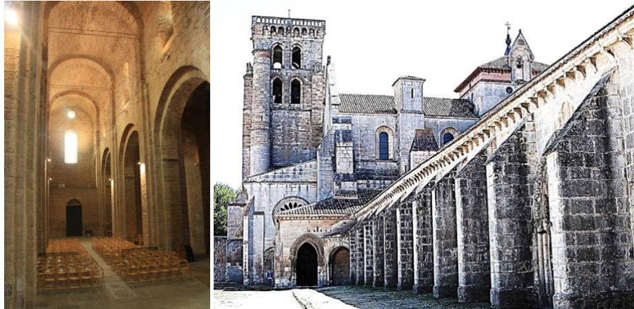
Esquerra: nau i arcs faixons de l'església de Sant Vicenç de Cardona (Barcelona); dreta: contraforts al monestir de Santa María de las Huelgas de Burgos.
