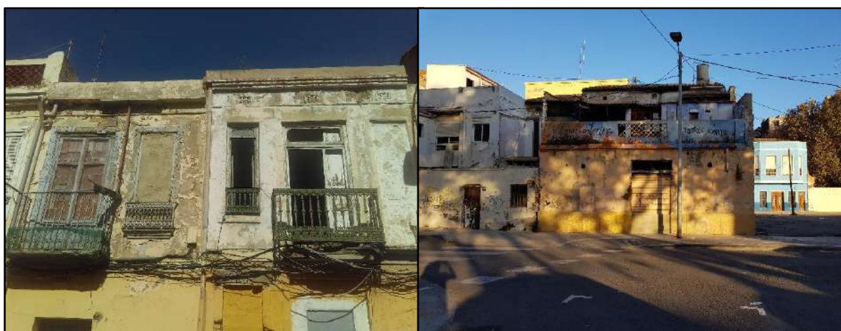
Foto.13. Clădiri degradate în cartierul Cabanyal
