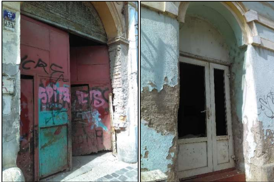
Foto.21. Intrări ale unor clădiri de pe Strada Dacilor, zona Traian
