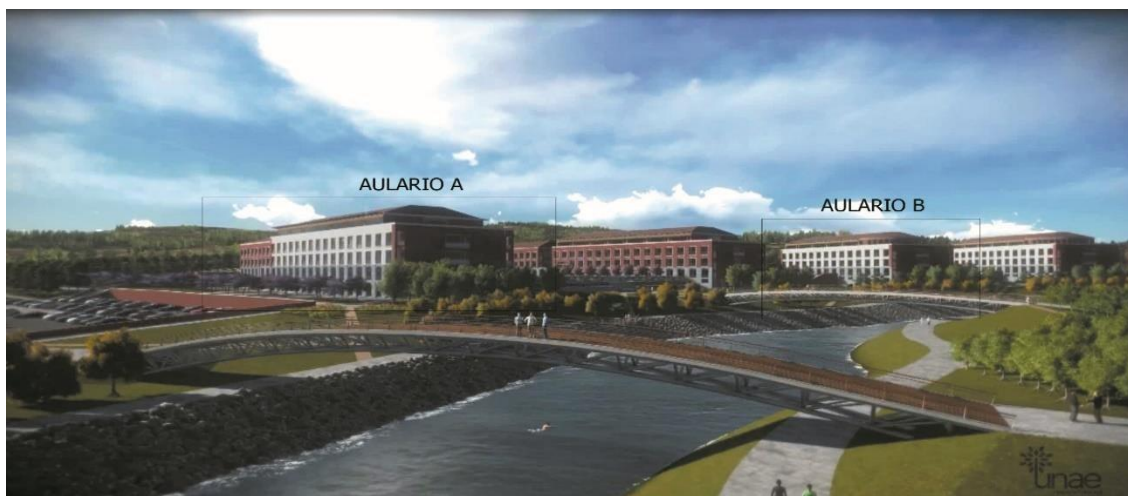
Imagen 1. Edificios aularios A y B. Campus universitario de la UNAE. Fuente: Proyecto de creación de la Universidad Nacional de Educación.
