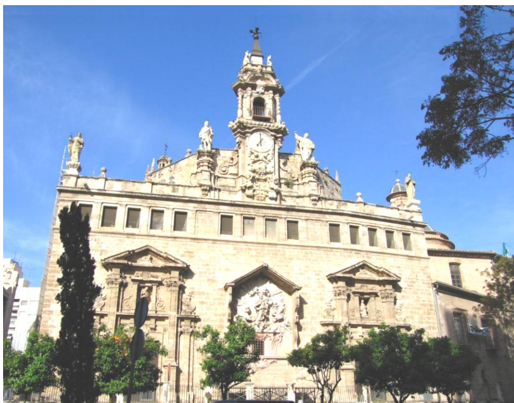
Fig. 24 - Iglesia de los Santos Juanes. Fachada de la plaza del Mercado.
