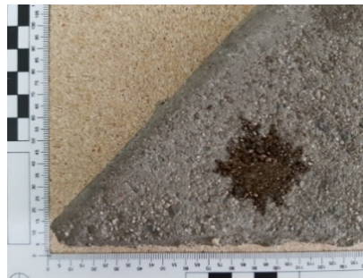
Figura 11: Mancha sobre hormigón
