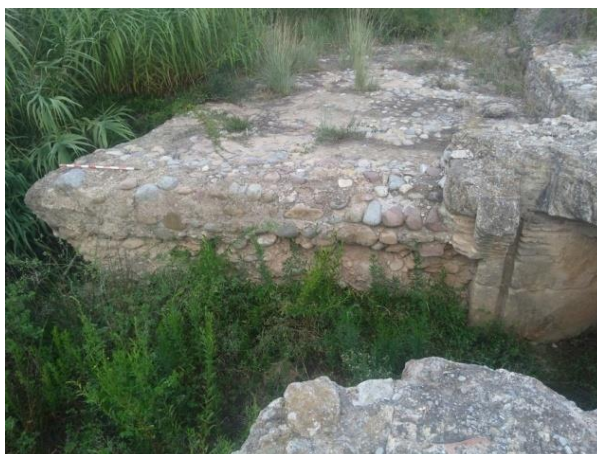
Imatge 79. Mur d'argamassa del portalet de Borriana per facilitar el regolf. 902
