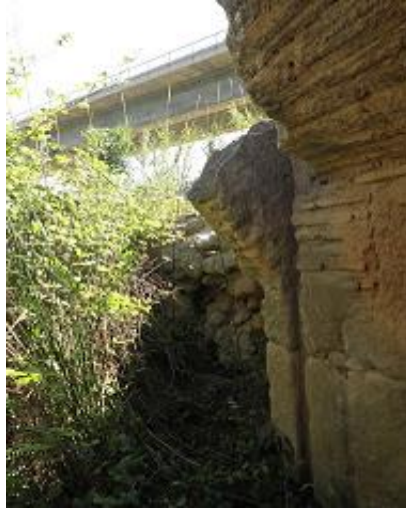
Imatge 29. Detall de l'arrencada dels arcs de rajola del «portalet de Borriana». 248
