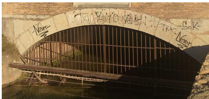
Imatge 61. Detall del ferros de la Caixa de les Reixes d'Almassora. 652
