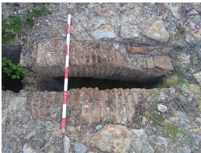
Imatge 75. Detall del portalet que permetia passar l'aigua fins a l'assut de Borriana. 871
