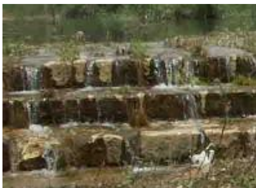
Imatge 20. Detall dels escalons de l'assut de Mestalla. 186
