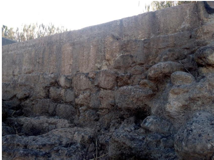
Imatge 87. Detall de diferents etapes constructives a l'assut de Borriana. 1074
