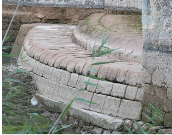
Imatge 65. Detall del rearc de l'assut de Vila-real. 777
