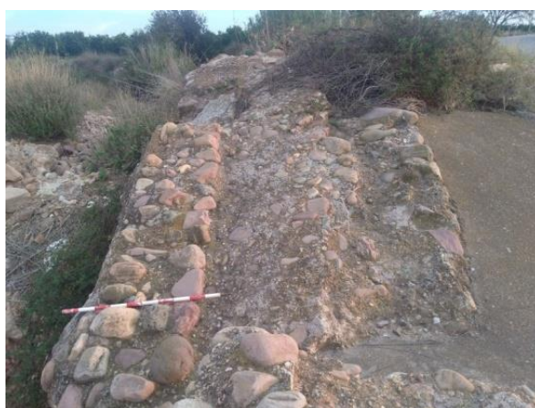
Imatge 39. Detall d'una «travessa» d'argamassa al riu Sec de Vila-real. 301
