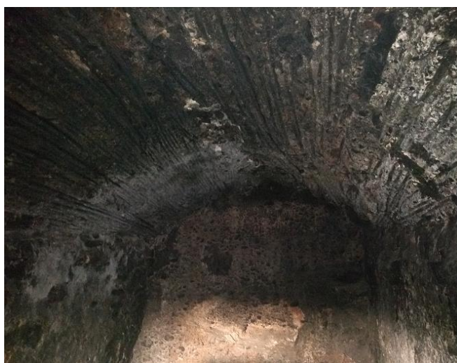
Imatge 44. Detall de la volta d'aljub de la Caseta dels moros a Almassora. 320
