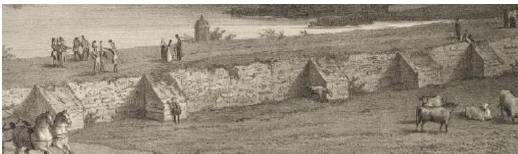
Imatge 23. Detall dels contraforts de la presa d'Ontígola el 1832. 199
