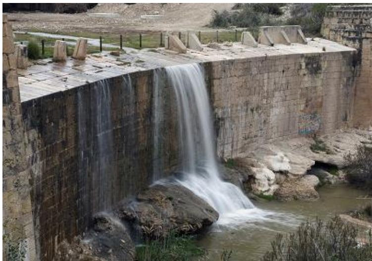
Imatge 15. L'assut de Sant Joan d'Alacant és un exemple de presa amb planta corba. 172
