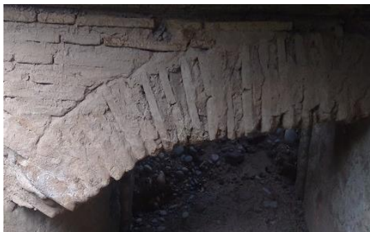
Imatge 57. Ús de rajoles al naixement d'una sèquia de mitjans del segle XVI. 591
