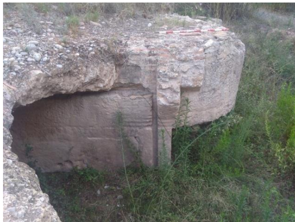
Imatge 78. Detall dels elements de pedra picada del portalet de Borriana per facilitar el gir de l'aigua. 898
