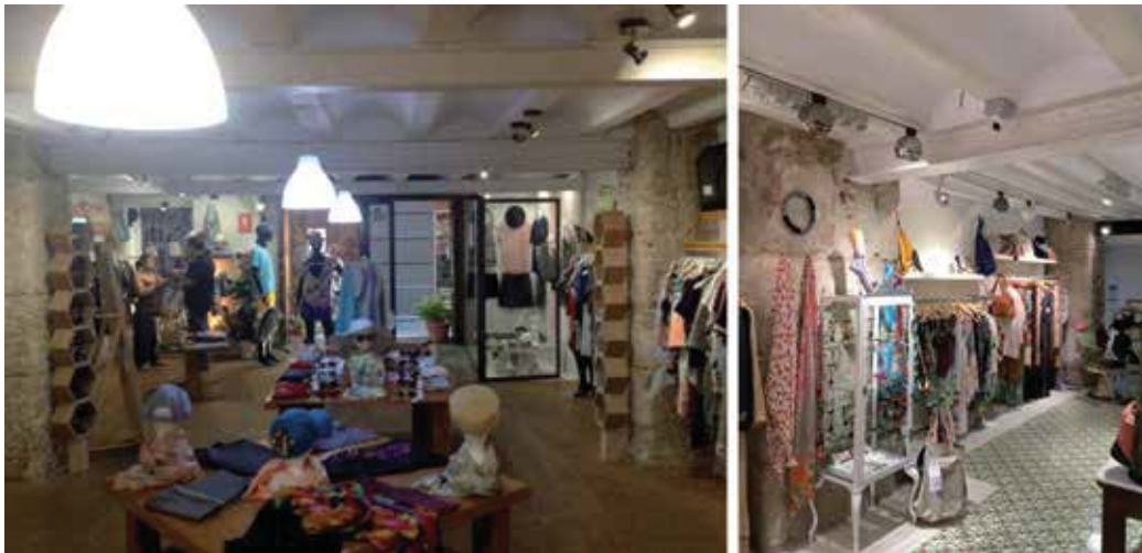
Fig. 5a.- Pilastras en Danzas nº 3 izquierda y Fig. 5b. Pilastra en Danzas nº 3 derecha, donde se percibe el degollado para empotrar la jácena metálica y la pendiente común a todos los bajos.
