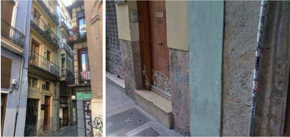
Fig. 4a.- Ruptura de alineación de Compañía nº 3 y Fig. 4b.- Continuidad evidente entre Danzas nº 1 y Danzas nº 3, pese a las intervenciones posteriores.
