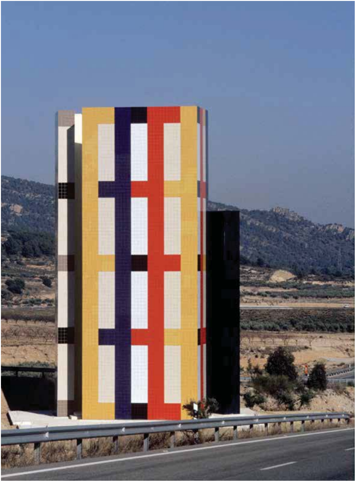
Fig. 12.- Sense título . 700 x 2000 x 650 cm. 1999. Revestimiento de azulejo con esmalte cerámico sobre estructura de hormigón.
