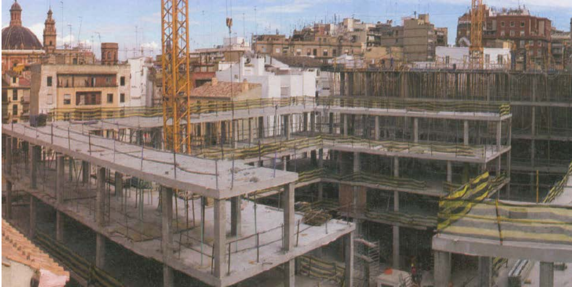
Imagen 10. Obras de construcción de viviendas de protección oficial en Velluters (2006).
