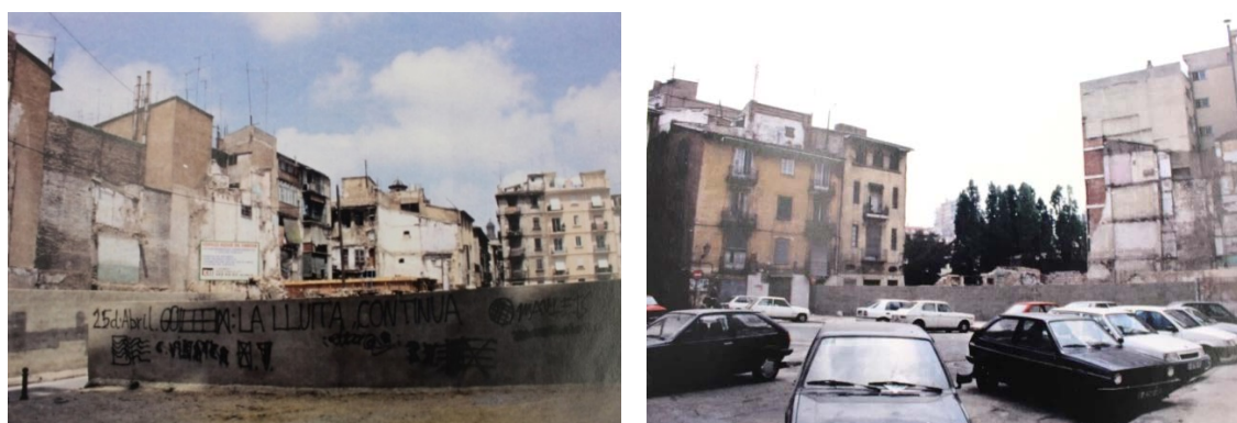
Imagen 7. Solares y edificios en ruinas en Velluters. Fuente: Memoria fotográfica de la Propuesta de actuación de Velluters (Generalitat Valenciana, 1994).
