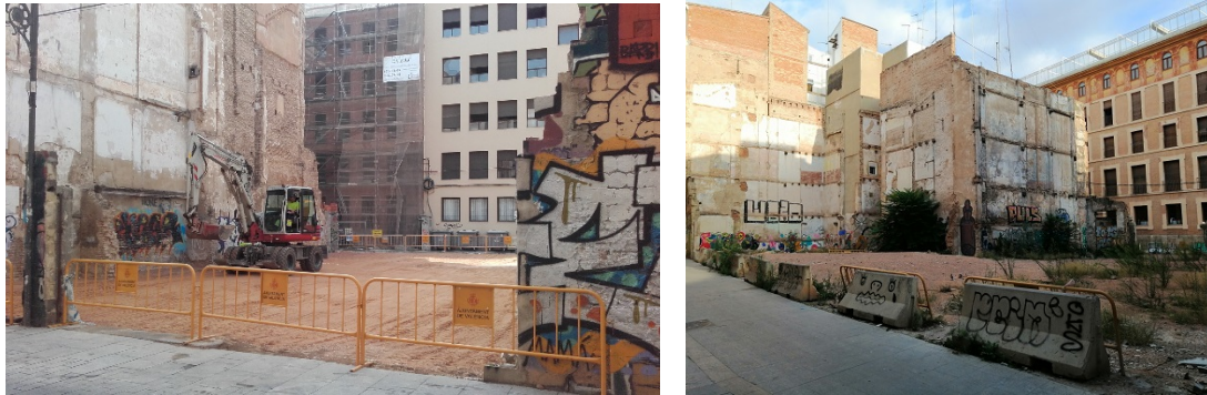
Imagen 35. Desmantelamiento de muros en solar de calle Balmes (2018). Fuente: Fotos propias.
