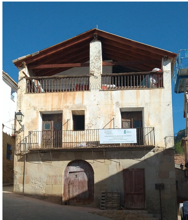
Figura 4. Fachada de “la casa del Tío Florencio” en pleno proceso de rehabilitación para convertirse en La casa de las Luces.
