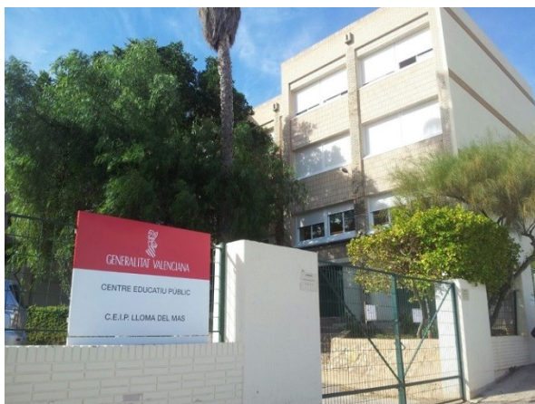
Figura 24. Vista de la entrada del CEIP.
