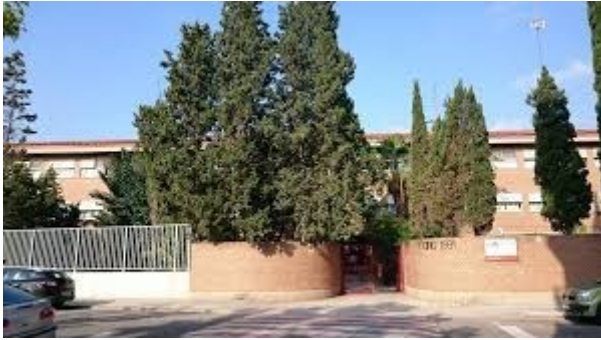
Figura 25. Vista de la entrada del CEIP.
