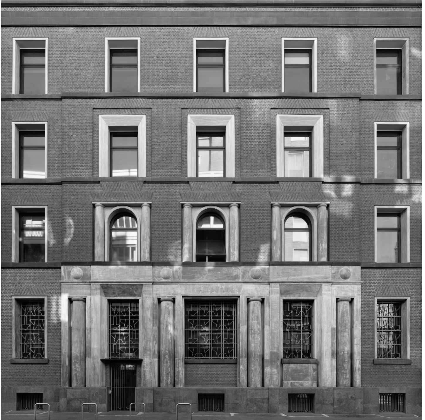
Camera del lavoro (entrée latérale), anciennement Casa dei Sindacati Fascisti dell'Industria, arch. Mario Palanti, Antonio Carminati, Angelo Bordoni, Luigi Maria Caneva, 1929-1933
